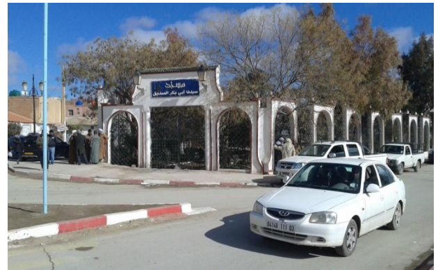
Figure 45 : vue de Mosquée Abo Baker EL-Sadik Source : par www.google maps image d'Aflou.com
