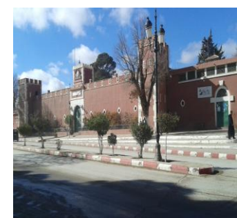
Figure 74 : Siège de la daïra de la ville d'Aflou Source : prise par l'auteur
