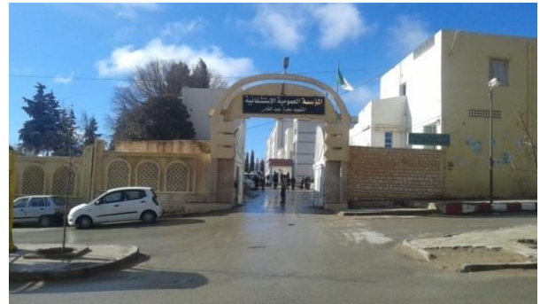
Figure 49 : vue de Bibliothèque Istiklal Source : par les auteurs le 23 janvier 2018 heure 15 :45
