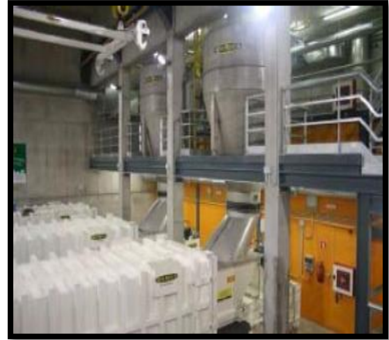
Figure28 : vue intérieure centre de collecte
