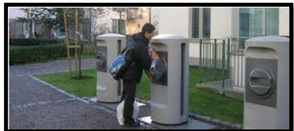
Figure 05 : Collecte systèmes pneumatique
