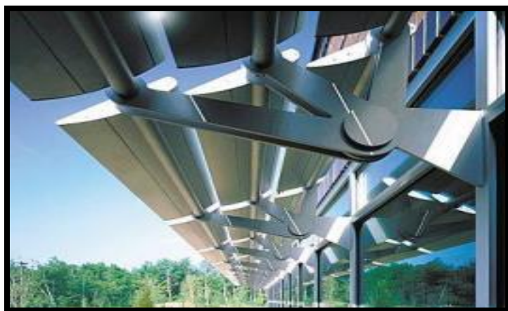
Figure 20 : Brise soleil photovoltaïque avec lames amovible./source: Doucement le photovoltaïque en région wallonne(le plan solwatt)
