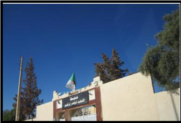
Figure87 : CEM Nouaser Ibrahim /source : auteurs
