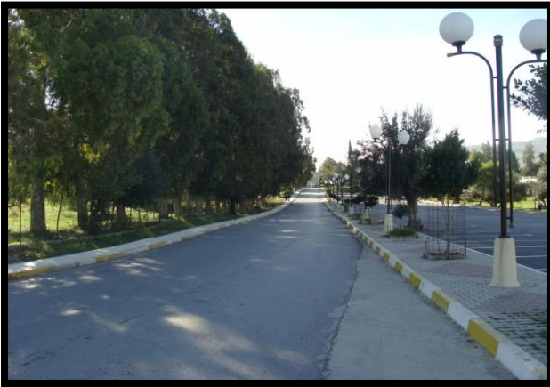
Figure28 : voie mécanique vert le projet Source : /www.facebook.com/Complexe-thermal-Hammam-chellala
