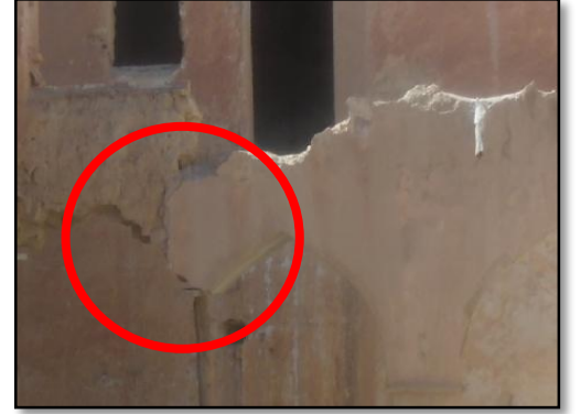
صورة رقم 98 توضح تدهور وتشقق الأقواس
