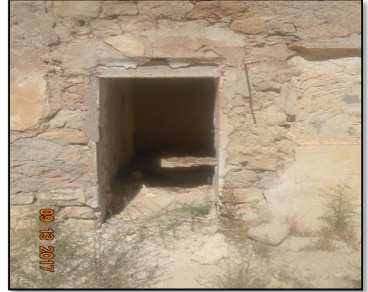
صورة رقم 96 توضح تدهور التلبيس
