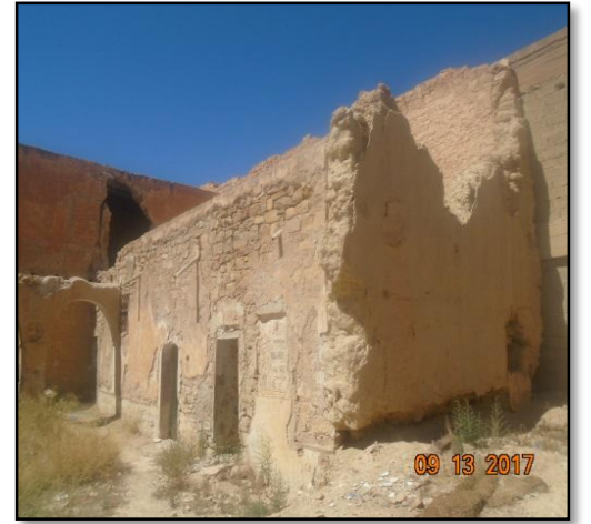
صورة رقم 98 توضح تدهور وتشقق الأقواس
