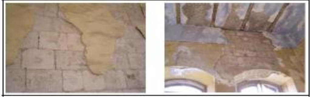
صورة رقم 18: القسارة التي تغطي الواجهات الداخلية. المصدر: محمد نجدي ناجي المصري : تقيم اساليب وترميم في فلسطين( نابلس حالة الدراسة)ماجستير 2010 جامعة النجاح الوطنية
