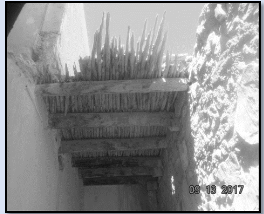
صورة رقم 97 توضح تدهور السقف
