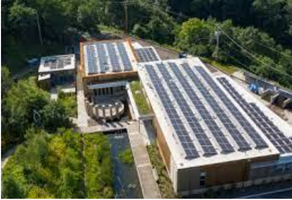
الصورة 120: الألواح الكهروضوئية المستعملة
