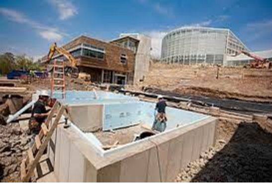
الصورة 123: خزانات المياه أثناء الإنشاء
