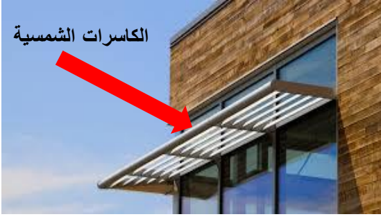
الصورة 110: الكاسرات الشمسية للمبنى
