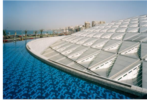
الصورة 140: تركيب السطح الخارجي لمكتبة
