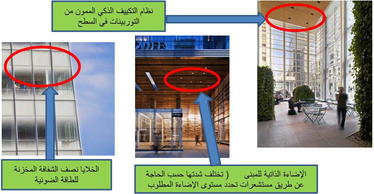
الصورة 144: خلايا تخزين الطاقة و الإضاءة
