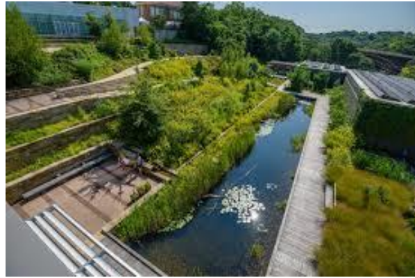
الصورة 121: خزانات معالجة المياه عن طريق النباتات
