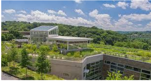
الصورة 112: منظر عام لسطح المبنى
