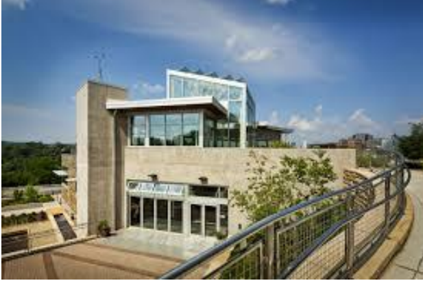
الصورة 100: منظر خارجي لسطح المبنى
