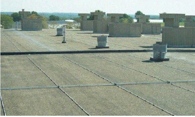
الصورة 115: محطة تنقية الهواء في سطح المبنى
