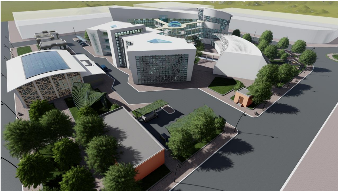
الصورة 224: الألواح الكهروضوئية فوق سقف قاعة الرياضة
