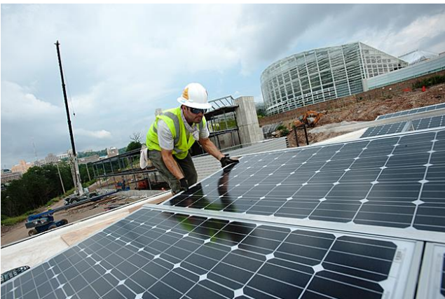
الصورة 126: الألواح الكهروضوئية المركبة في المبنى
