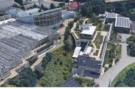
الصورة 82: منظر جانبي لمركز المناظر الطبيعية
