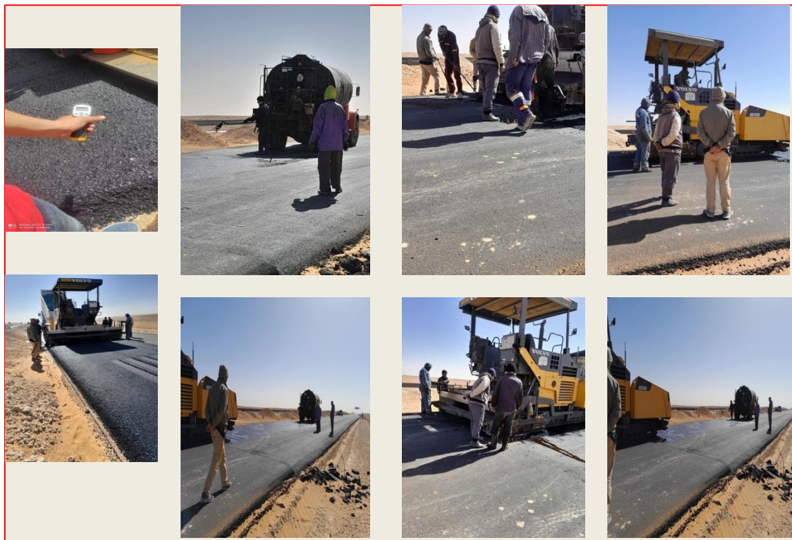
Figure : Une collection de figure de la visite de chantier.
