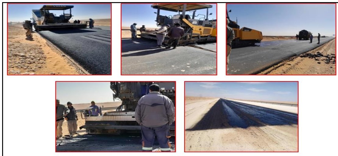
Figure IV. 11: Revêtement : Béton bitumineux (BB).
