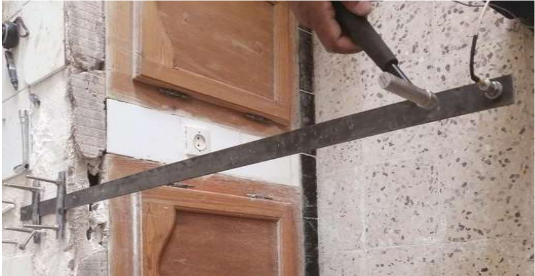
Figure 19 : Montage d'une poutre pour l'essai dynamique
