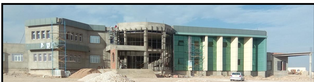
FIGIII.76 : façade principale les 14 labos nouveaux pôle universitaire ; source : auteur.
