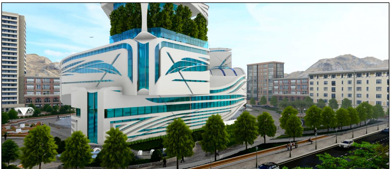
Figure 17 : Vue d'angle du projet
