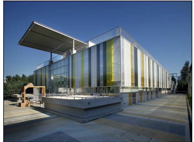
Figure 1 : Centre de recherche en architecture Source : www.archdaily.com
