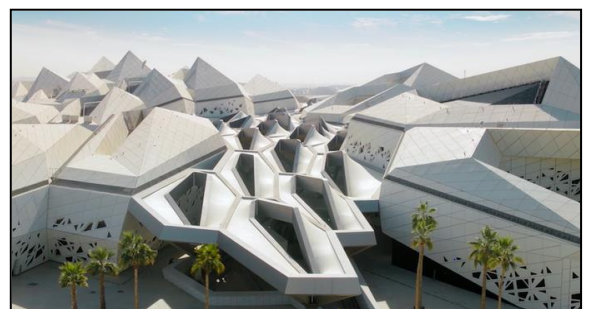
Figure 29 :Façade blanche du KAPSARC Source : www.floornature.eu/zaha-hadid-architects-centre-de-recherche-kapsarc-riyad
