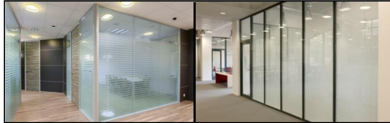
Figure 52 Cloisons vitrés avec stores Source : www.espace-cloisons-alu.fr
