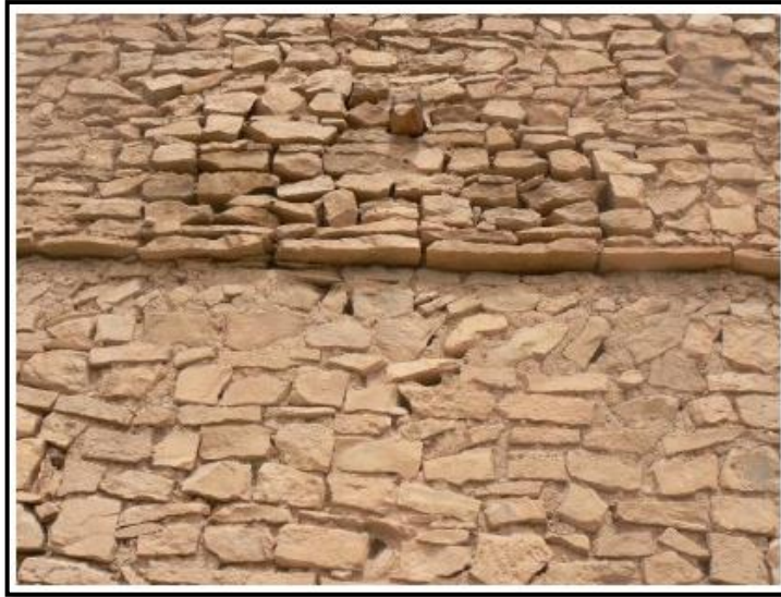
Figure 53 : Style de touiller dans les murs. (Source par l'auteur)
