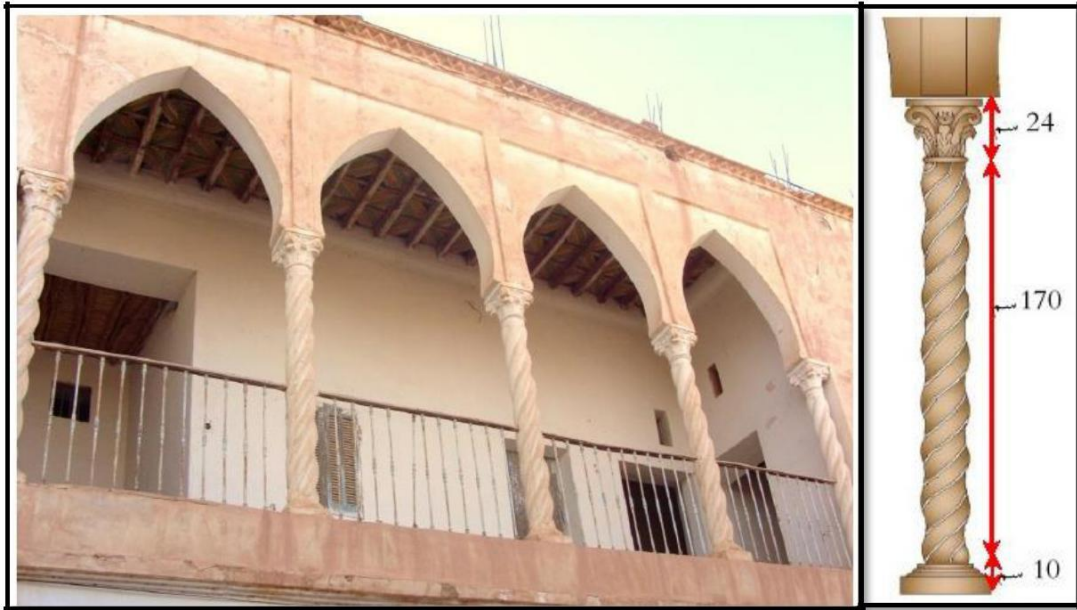
Figure 62 : Coupe schématique des Colonne décoratif. (Source par l'auteur)
