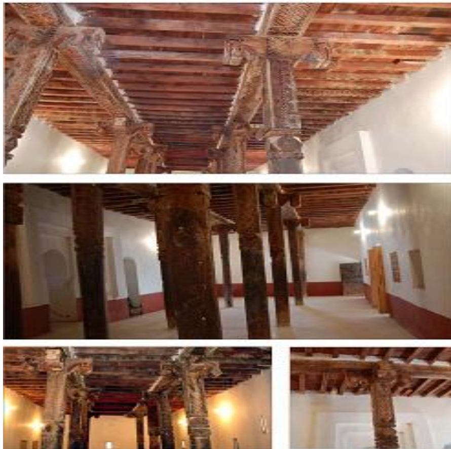
Figure31 : photo représente la salle de prière après la finition des travaux Source: réhabilitation de la mosquée TimzguidaUkhriben .S.Nadji
