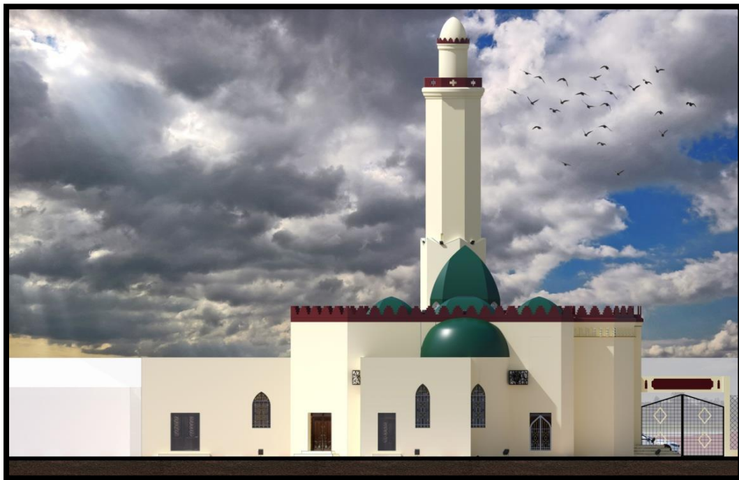
Figure 152: façade latérale de la mosquée après la réhabilitation source: auteur
