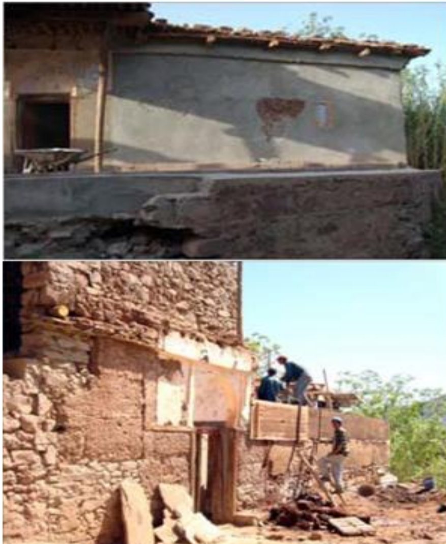
Figure 28: photos représentent les murs d'extérieur avant et après l'achèvement de pisé Source: réhabilitation de la mosquée TimzguidaUkhriben .S.Nadji
