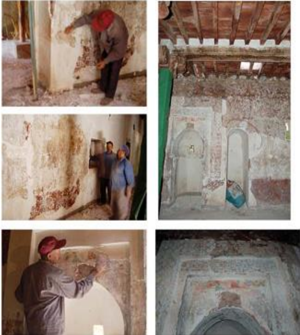
Figure 24 :photo représente travaux de décapage de mur Source: réhabilitation de la mosquée TimzguidaUkhriben .S.Nadji
