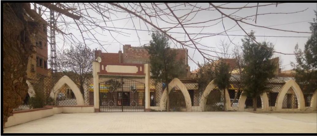
Figure 60: photo de galerie qui entoure la mosquée Source :auteur
