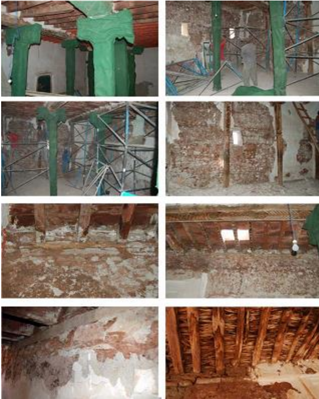
Figure23 : photo représente les travaux de décapage de mur Source: réhabilitation de la mosquée TimzguidaUkhriben .S.Nadji
