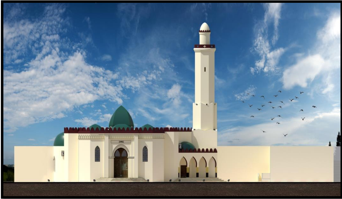
Figure 151: la façade principale après la réhabilitation source: auteur
