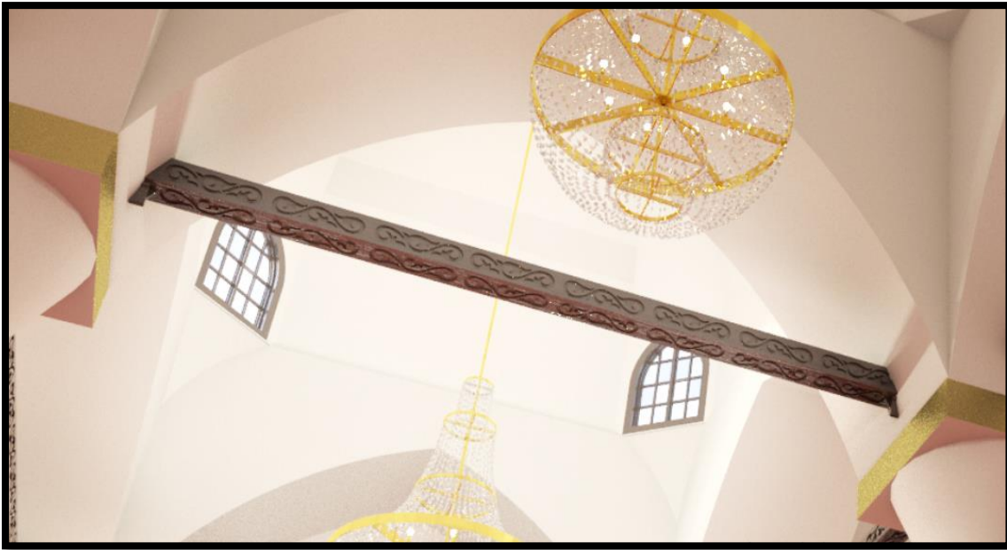
Figure 143: photo des éléments décoratifs utilisés comme couvre câbles source: auteur
