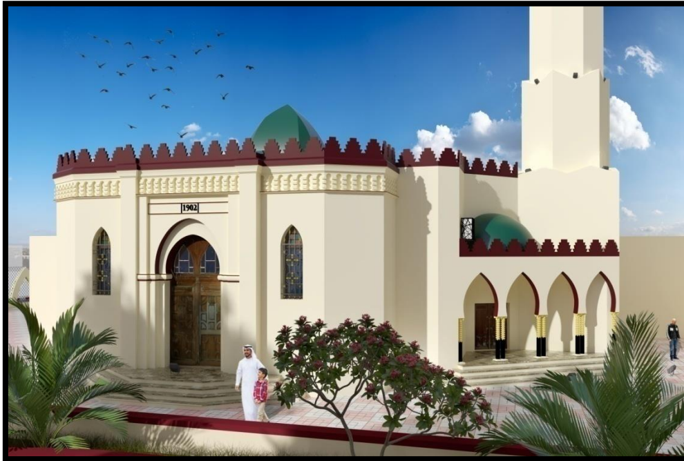
Figure 153: vue globale sur la mosquée après la réhabilitation source: auteur
