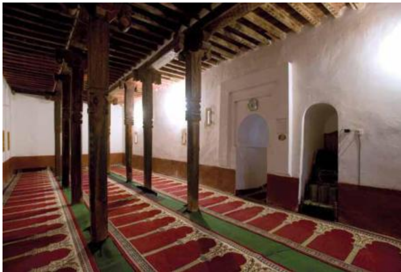
Figure18.: la mosquée TimzguidaUkhriben .S.Nadji Source: réhabilitationde la mosquée TimzguidaUkhriben .S.Nadji
