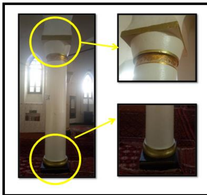
Figure 69: photo montre le détail d'une colonne dans la mosquée Source: auteur
