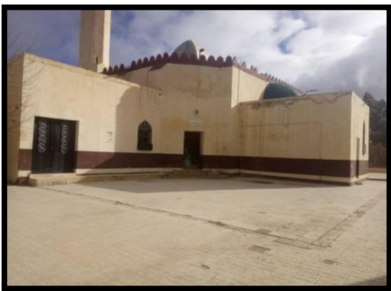
Figure 92: façade ouest de la mosquée Source: auteur
