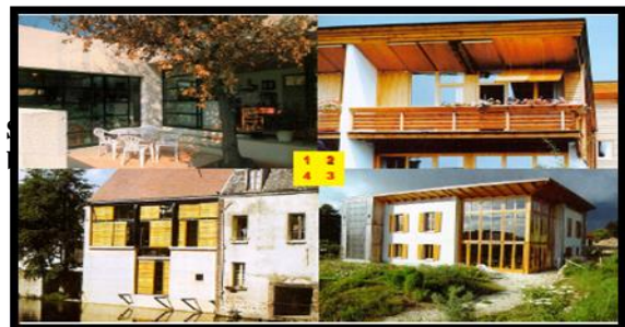
Figure 27: exemples de quatre types de protections solaires
