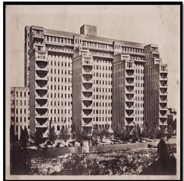
Figure 11: Hôpital Beaujon à Clichy, conçu par Jean Walter.
