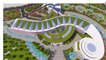
Figure 282: Panneaux solaires dans la toiture
