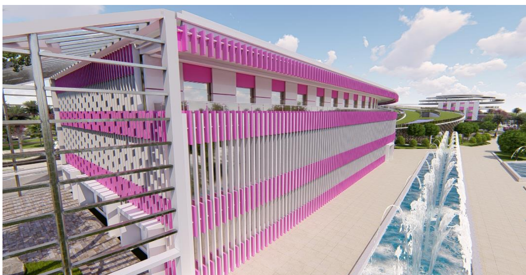
Figure 217: les brises solaires verticales dans la façade principale
