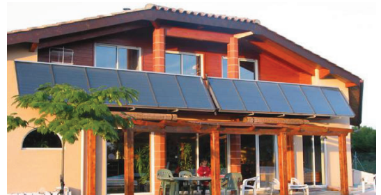
Figure 8 : Maison équipée de panneaux photovoltaïques
