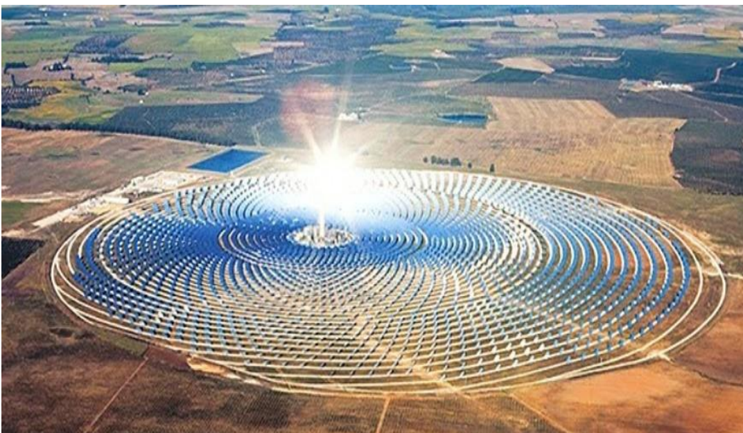
FIGURE I.11 – Center solaire thermique
