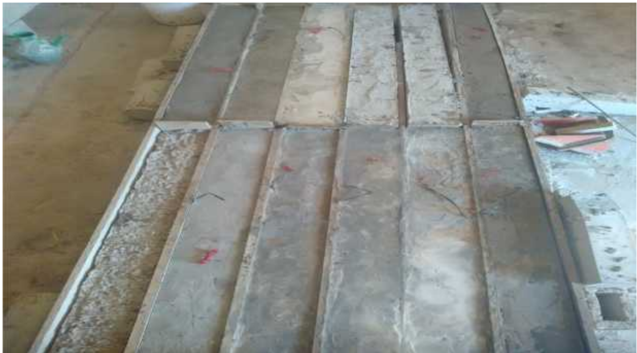
Figure 5.11 : Les poutre réparé apprêt placement des jauge
