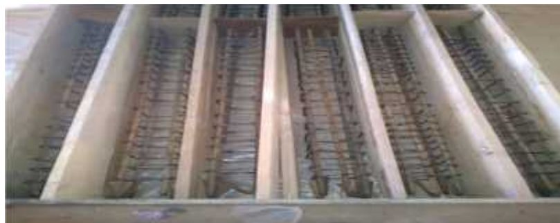
Figure 2.15: Ferrailage des poutres 20 \times 15 \times 150 \text{ cm}^3
