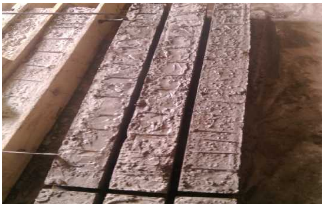
Figure 5.2 : Préparation de la surface de réparation d'une poutre.
