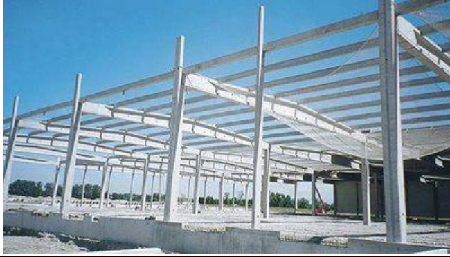
ossature poteaux- poutre en BAP
