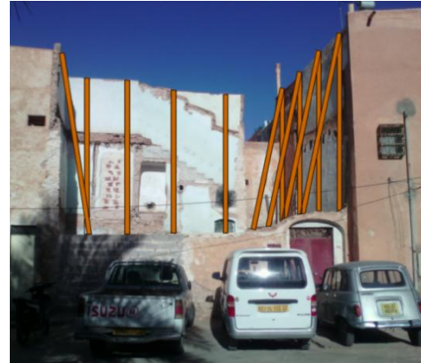
Figure 141 : Etaiment des maisons voisines. Établir par les étudiants.
