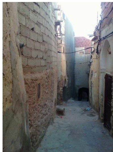
Figure 88: L'hétérogénéité des matériaux au niveau de façade. Pris par les étudiants
