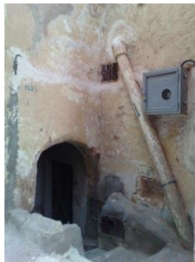
Figure 101 Compteur de gaz apparent. Pris par les étudiants
