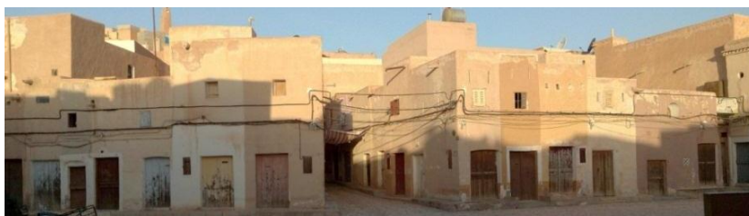
Figure 171: façade Nord de la place Lala Achou. Élaborer par les étudiantes.
