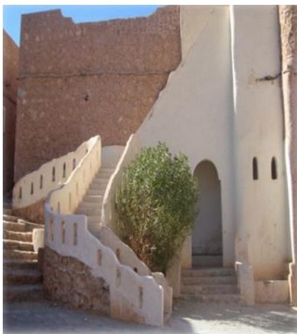
Figure 17: vue intérieur du ksar. [20]
