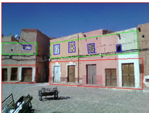
Figure 72: façades de marché. Pris par les étudiants
