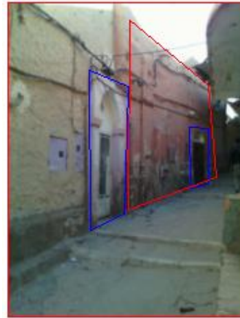
Figure 74: façade d'habitation. Pris par les étudiants
