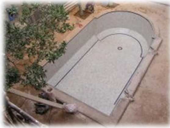
صورة رقم (10-1) بعد الانتهاء من القصارة بالزليج
