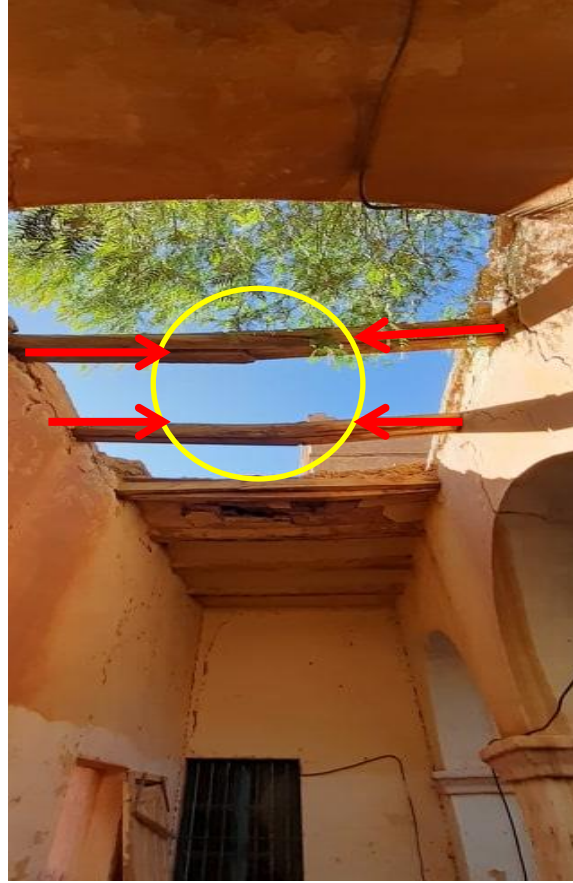
صورة رقم (3-6) صورة تلف بوسط عارضة السقف
