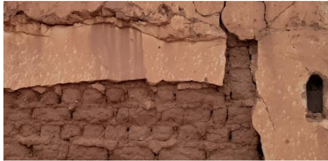
صورة رقم (2-15) جدار محلي مبني بالطوب
