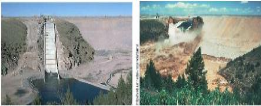
Fig. I. 7. Vue sur le barrage de Teton (USA) avant et après rupture
