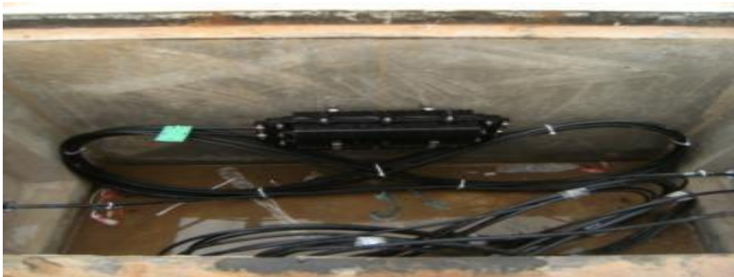
Figure II- 19 : Mise en place de joint et du love dans une chambre
