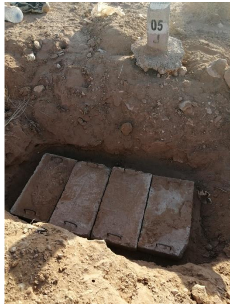
Figure III - 6 : Chambre BMH fermée
