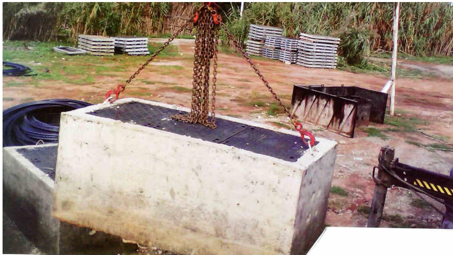
Figure II- 10 : Pose une chambre
