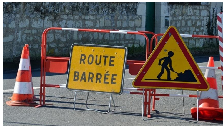
Figure III - 25 : Sécurisation de chantier
