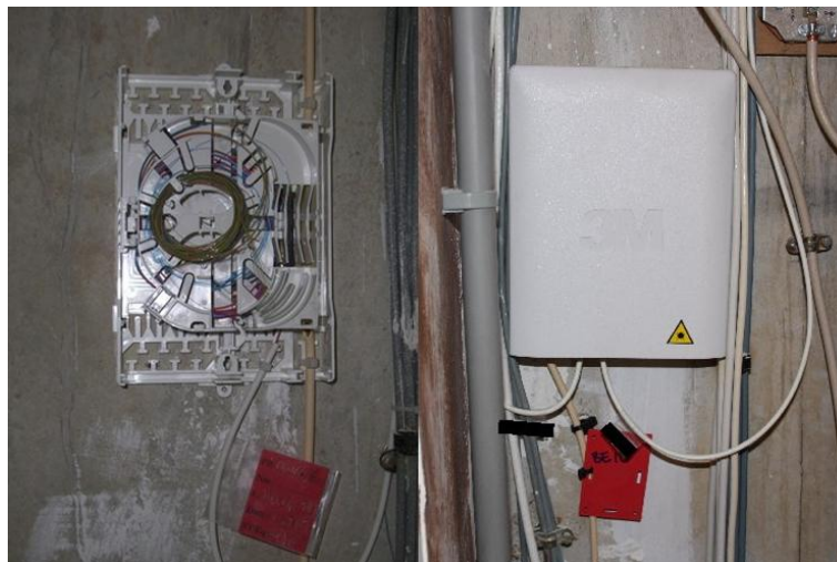
Figure I- 18 : Point de branchement optique
