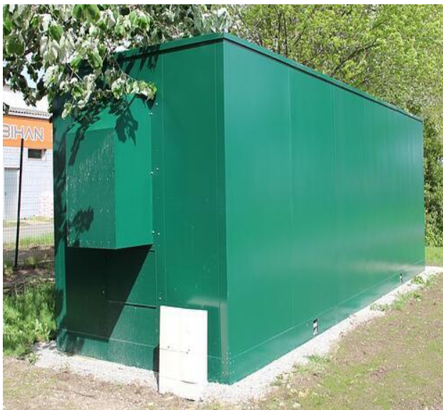
Figure I- 10 : Nœud de Raccordement Optique
