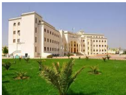
Figure 77: Siège de la wilaya. Source : https://mapio.net/pic/p-120606572/
