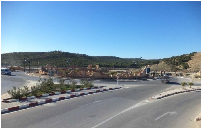
Figure 67: Carrefour RN 01-Evitement Est. Source : photo prise par l'auteur.
