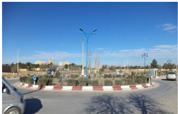
Figure 70: Nœud RN 01-Boulevard 2B, évitement ouest (sud). Source : photo prise par l'auteur.
