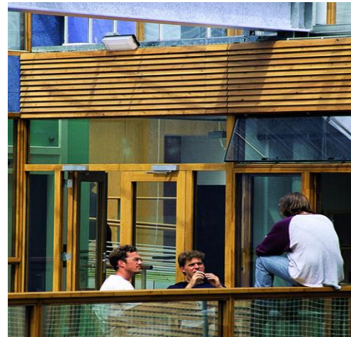
Fig. 08 : Parois vitrées sur l'atrium
