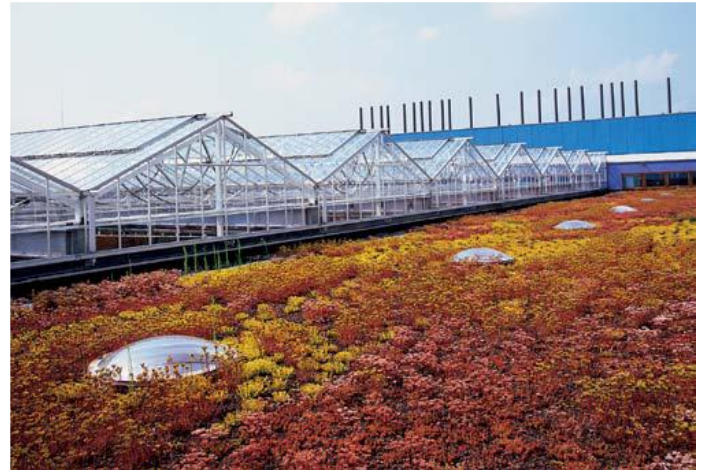
Fig. 10 : toiture végétalisée Source : BEHNISCH ARCHITEKTEN 2014
