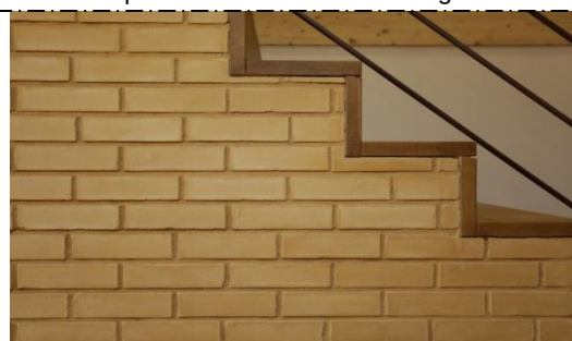
Figure V-9: Mur intérieur en BTCS.
