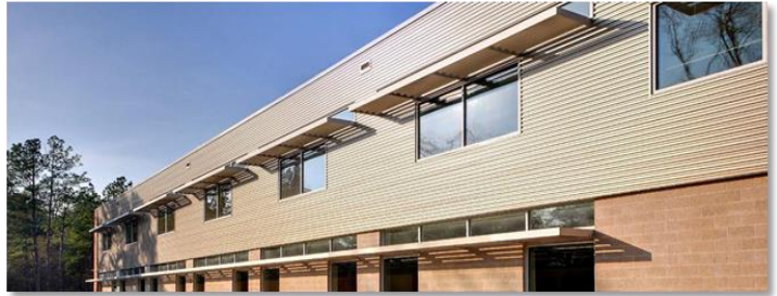
Figure I-45: Capteurs au niveau des fenêtres.
