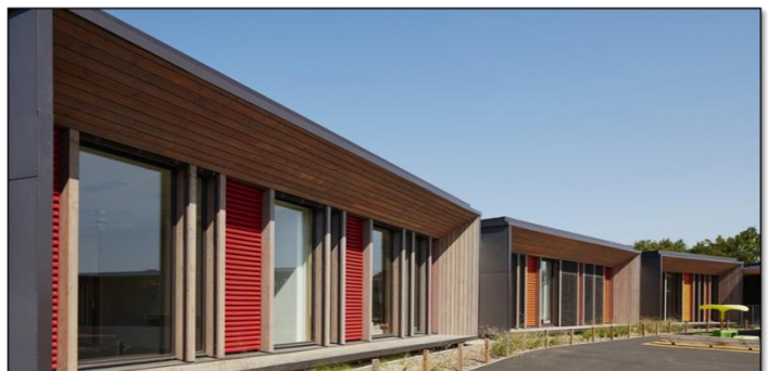
Figure I-18: Façade Sud de l'école Grézieu.
