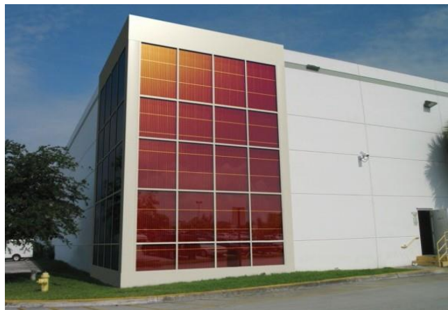
Figure V-23: panneaux photovoltaïque intégré.
