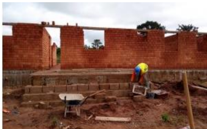
Figure V-8: Bloc de terre comprimé et stabilisé.
