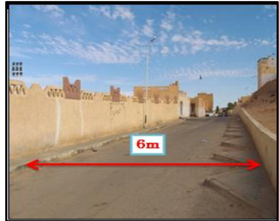
Figure 99: La voie tertiaire N°2
