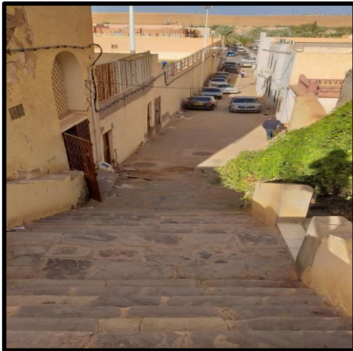
Figure 96: Les parois de la voie tertiaire
