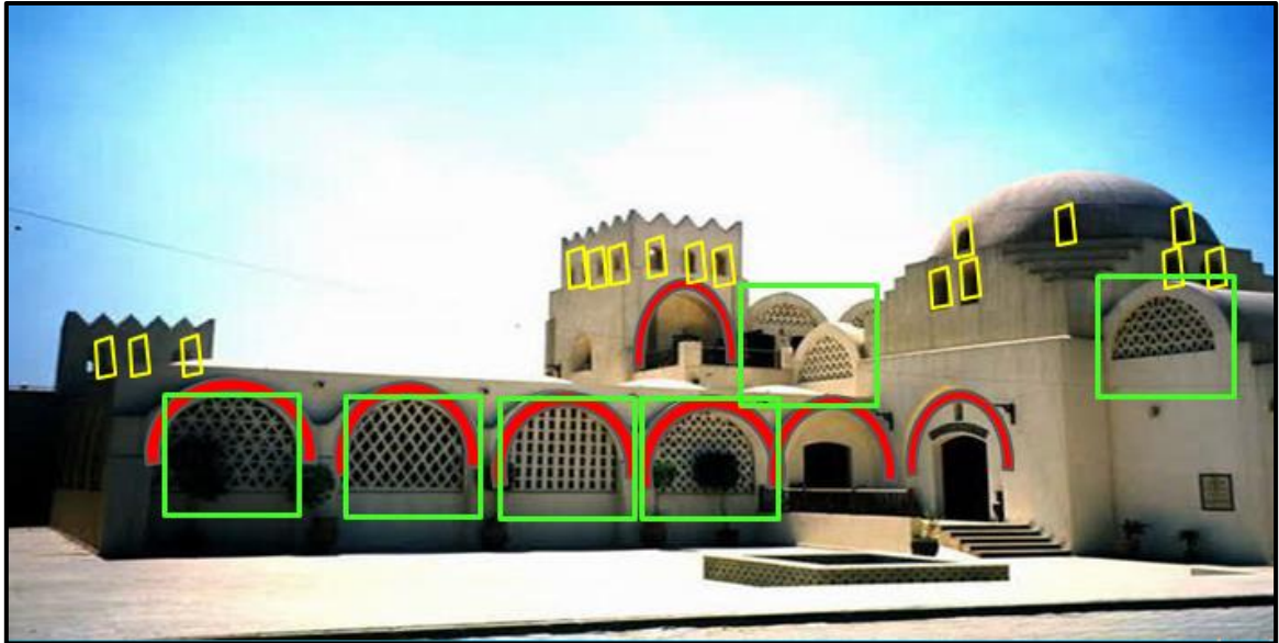
Figure 14: La façade principale du centre FUSTAT
