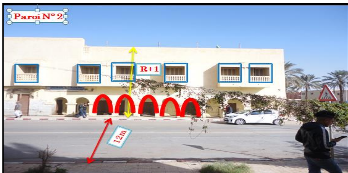
Figure 89: Paroi N°2 sur la voie principale
