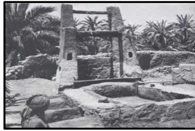
Fig II 21 : le puits de Ghardaïa, Source : google.com
