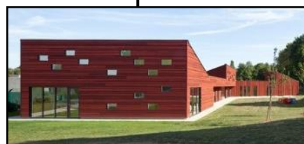
Fig I 59 : vue extérieur du projet
