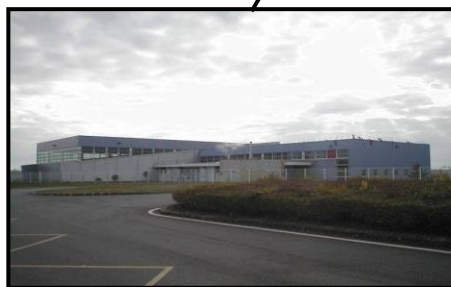
Fig. I 74 : la Salle Gymnase régional
