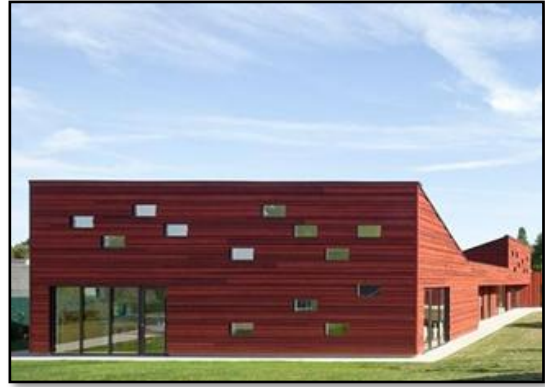
Fig I 86 : la façade NORD-OUEST Source : ArchDaily.com
