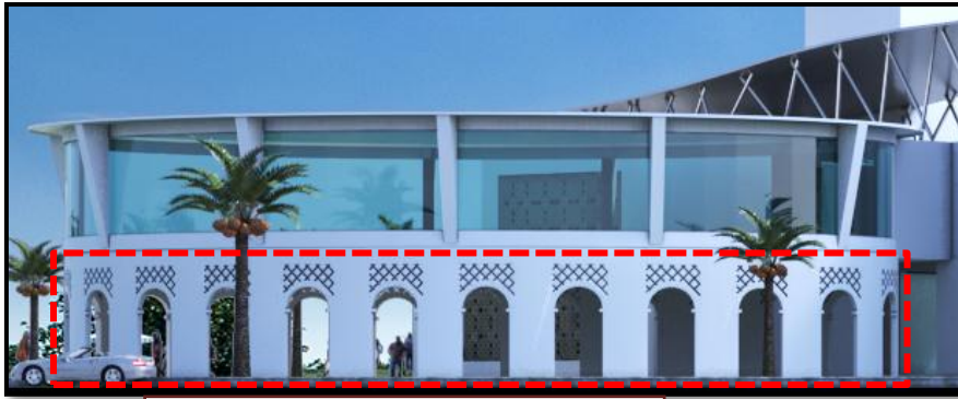
Fig IV 19 : vue aux niveaux des arcades Source : Auteur
