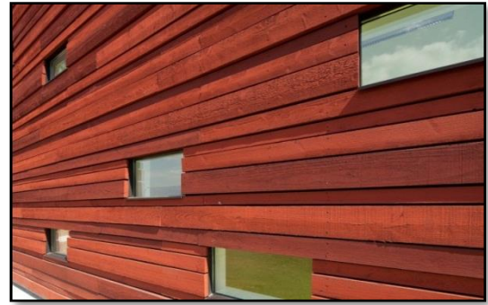
Fig I 82 : les petites fenêtres de la façade, Source : ArchDaily.com
