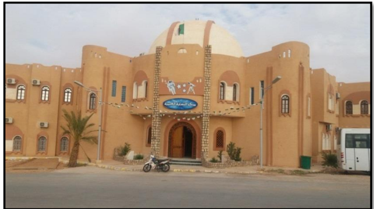
Fig I 37: le CLS de Ghardaïa Source : auteur
