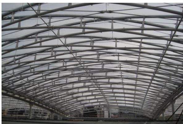
Fig 48: charpente métallique Source : cour superstructure 2année
