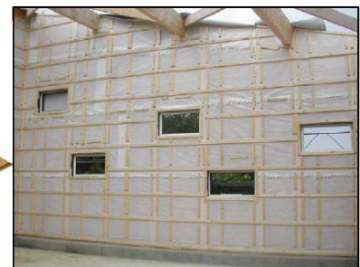
Fig I 99 : Vue intérieur de la structure en bois Source : ArchDaily.com
