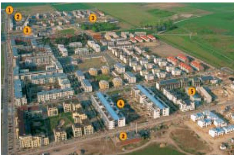
Photo II.61: Vision sur des installations énergétiques sur kronsberg [Guide du quartier de Hanovre - Kronsberg -Un modèle à vivre, un modèle à suivre]
