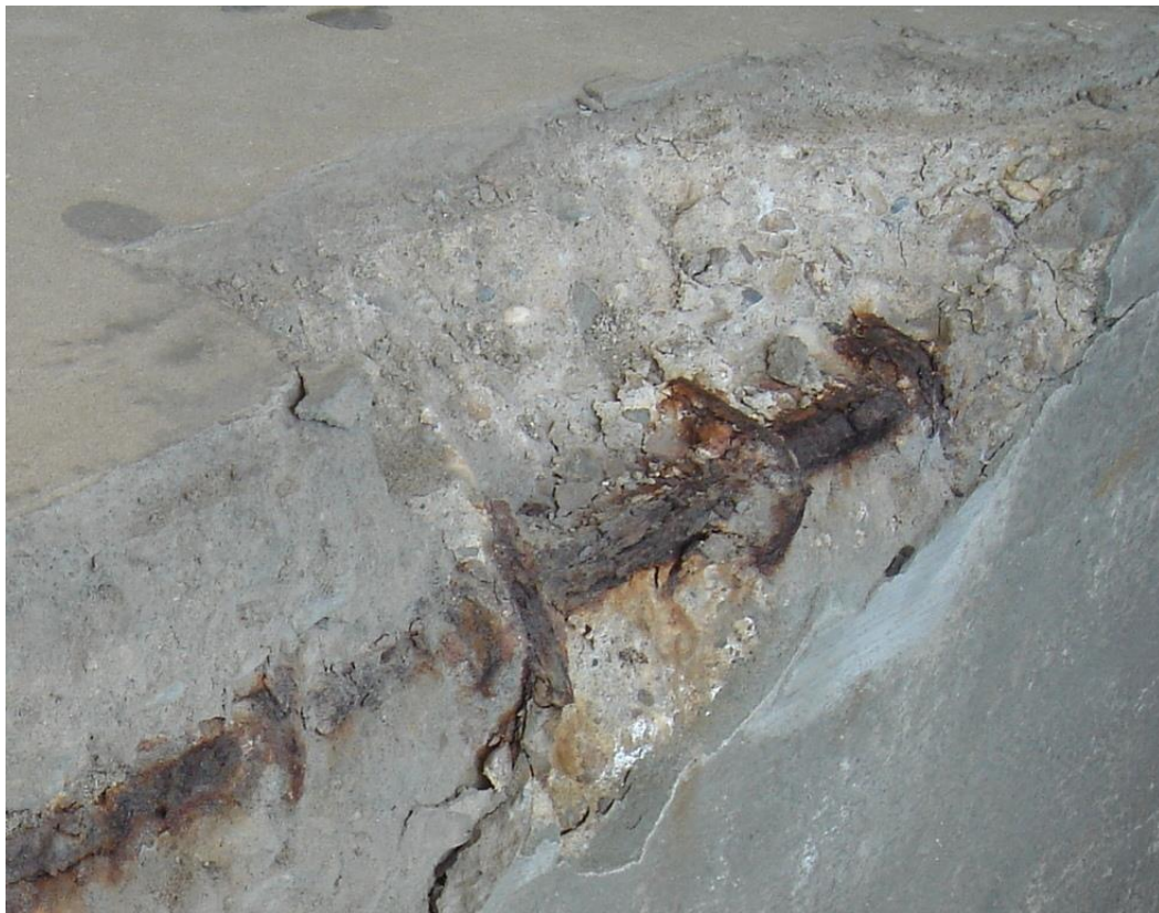
Fig II.6 : l'effet de la carbonatation
