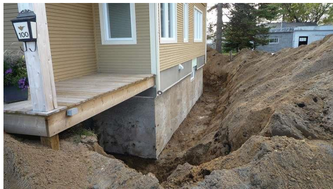
Fig III.5: Creuser la tranchée pour la pose du drain français [Ecohabitation, 2012].
