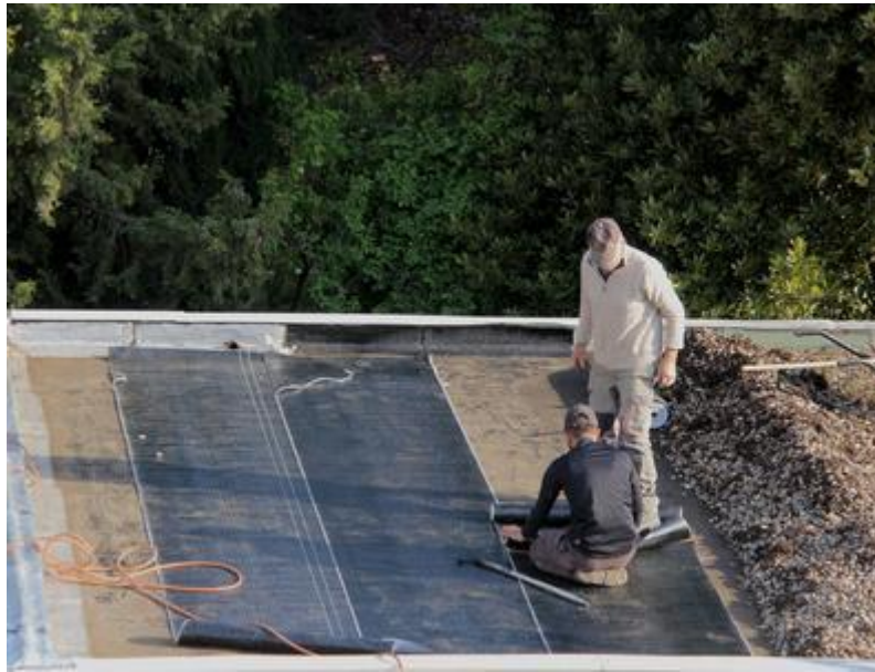
Fig IV.26 : Installation de membrane d'isolation
