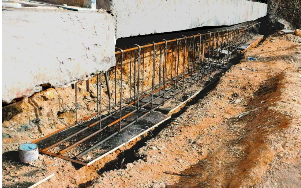
Fig IV.27 : Renforcement des fondations par des armatures supérieures.
