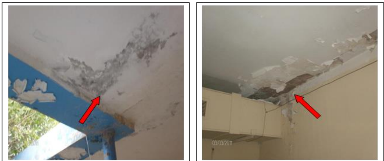
Fig IV.18 :Traces d'Humidité.
