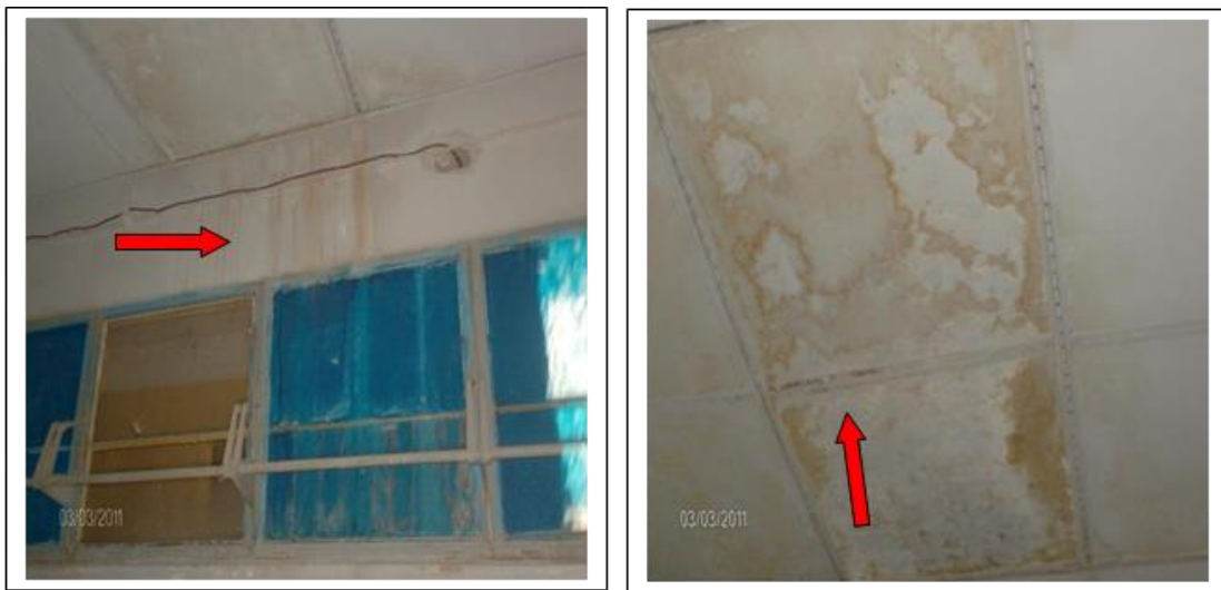
Fig IV.18 : Traces d'Humidité.
