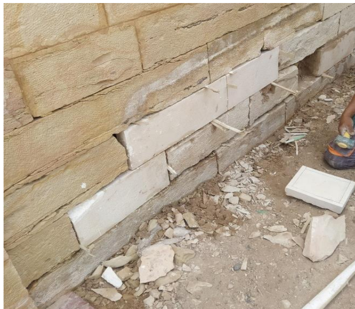
Fig IV.15: Remplacement des pierres endommagées.
