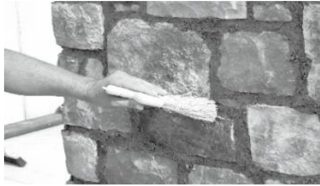
Fig III.9: Nettoyage général avec une brosse de paille [Geopietra, 2020].
