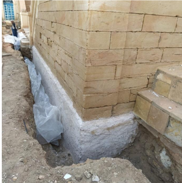
Fig IV.14: la technique de réparation par drainage.
