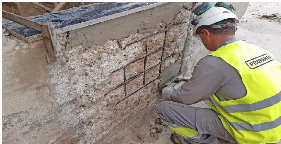
Fig III.2 : Réparation et protection du béton [groupe Propamsa, 2023].
