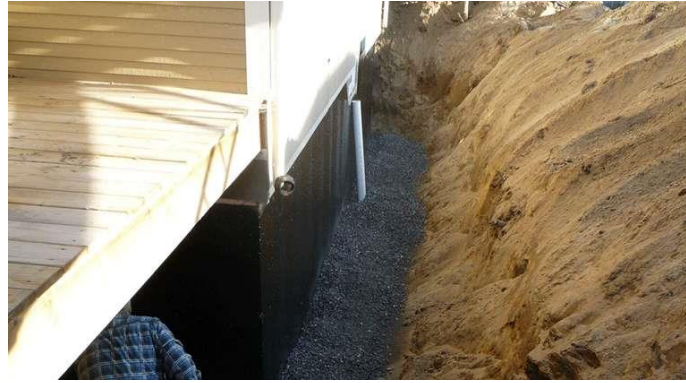
Fig III.6: Ajout du gravier sur le drain français [Ecohabitation, 2012].
