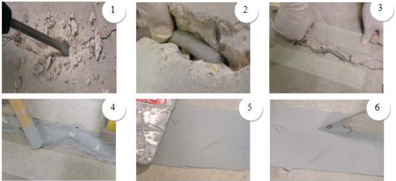
Fig III.3 : Le procédé de colmatage [Guide strres, 2007].
