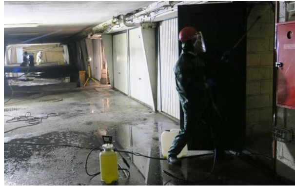
Fig III.1 : Un ouvrier au cours de processus de décontamination professionnelle [Dutheil. M. C, 2019].
