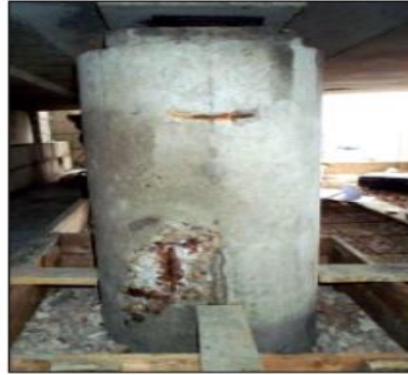
Pile de pont
