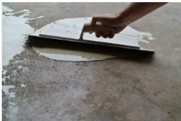
Figure II.23: Resurfaçage d'éléments en béton (dalle de sol).
