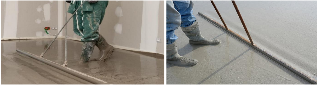
Figure I. 2 : Mise en œuvre des bétons autoplaçants.
