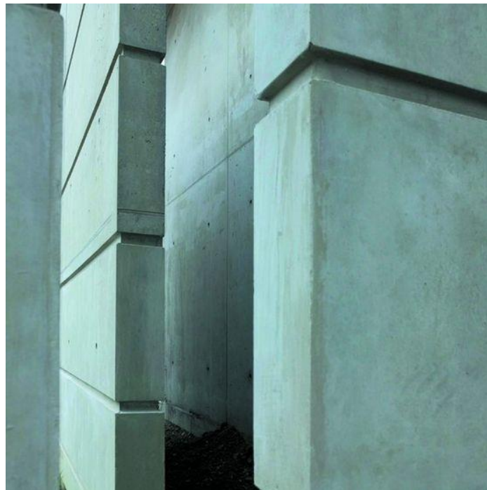
Figure I.1 : Béton autoplaçant pour des voiles
