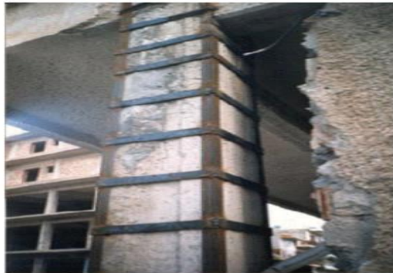
Figure II.17 : Chemisage en acier.
