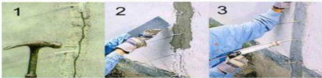
Figure II.19 : Réparation d'une fissure à l'aide d'une injection.
