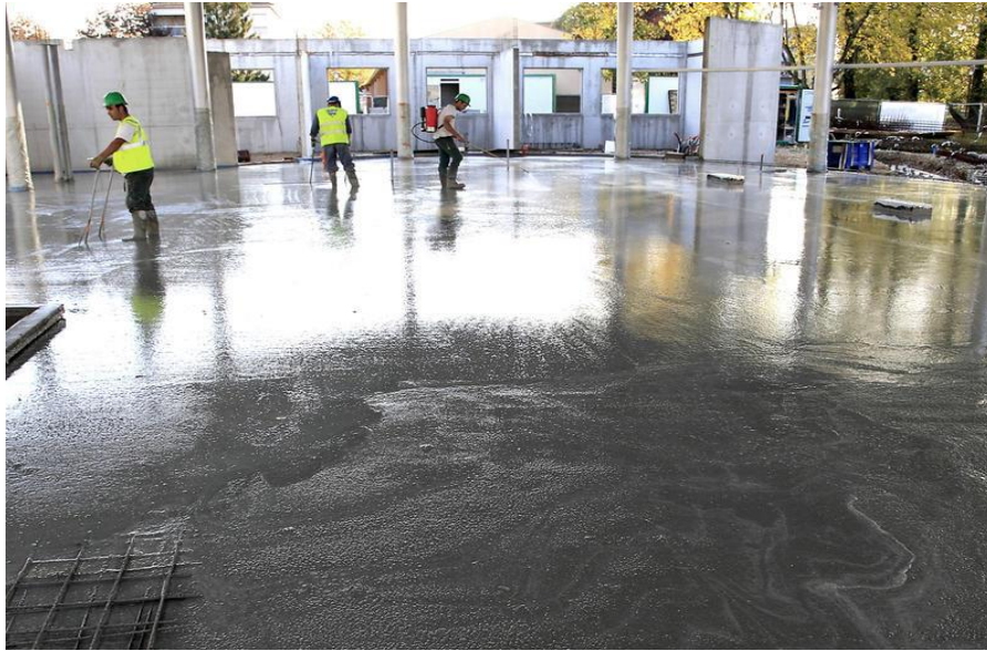
Figure I.5 : coulage en béton Autoplaçant.
