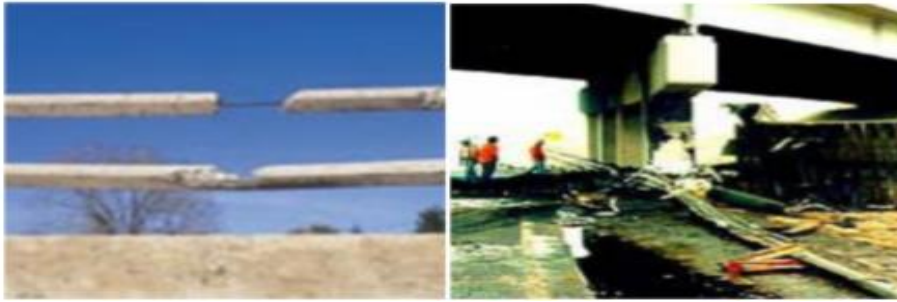
Figure II.3 : Choc sur une glissière de sécurité et une pile de pont.
