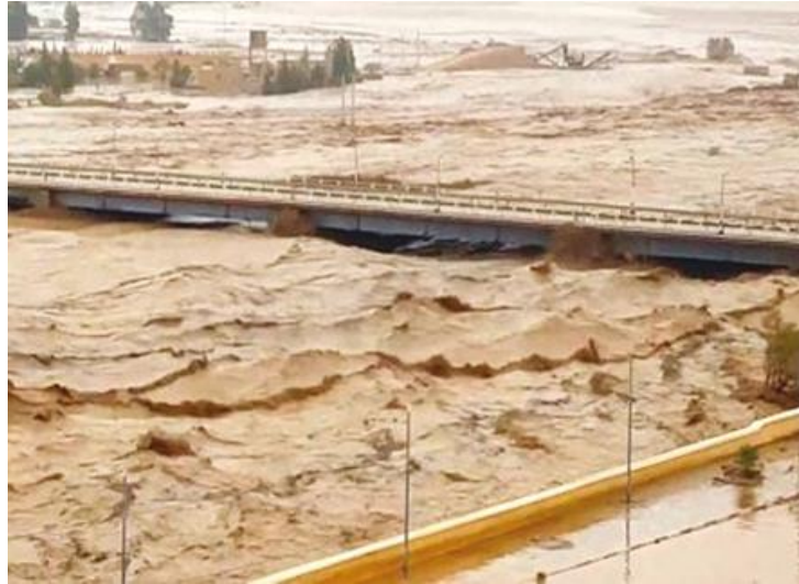
Figure 43: La crue d'Octobre 2016 (inondation de Barrage).
