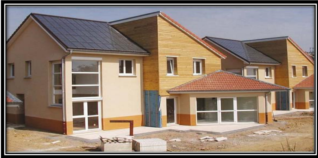
Photo. n°35: Panneaux solaires Source : Thèse sur l'électricité
