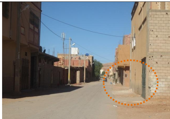
Photo .n°13: la détérioration du trottoir
