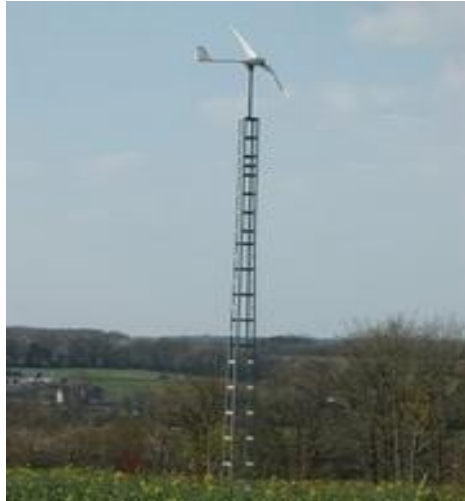
Figure II.2 Petite éolienne implantée sur un site agricole
