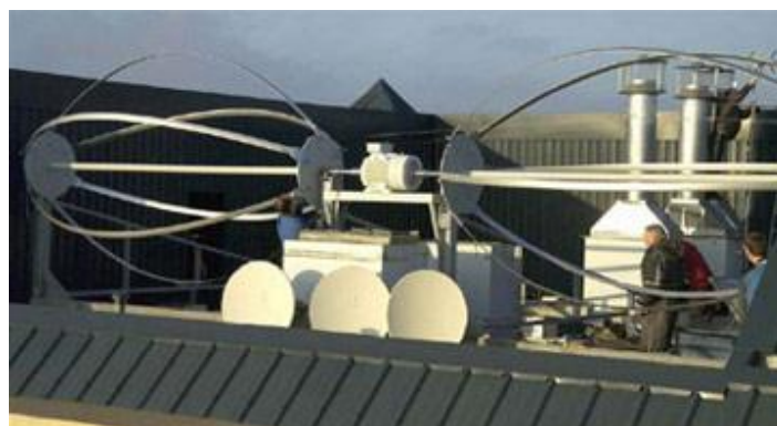
Figure II.10 - Eolienne urbaine à axe horizontal de type Darrieus constituée de 2 rotors de 5m de long.
