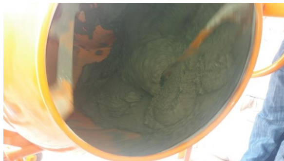
Fig.II-15 : Malaxage du béton
