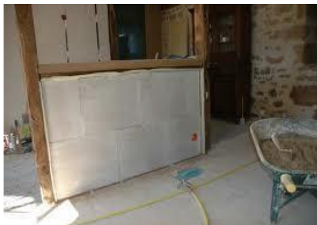
Figure I.16: Cloison en Béton de PSE Projeté.
