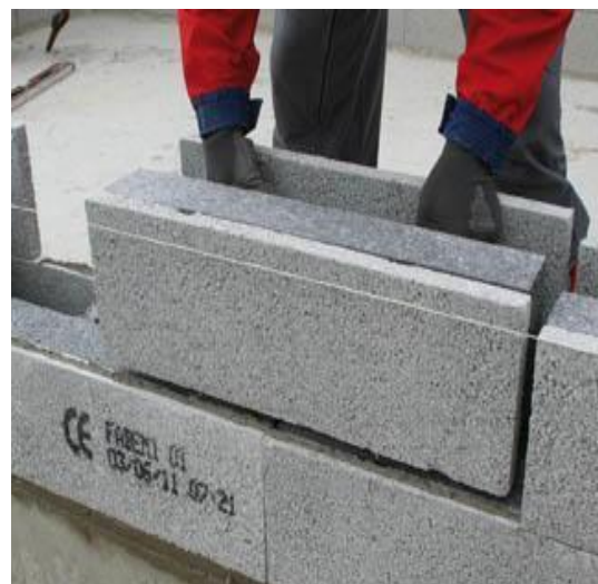
Figure I.15: Mur en blocs de béton de PSE.
