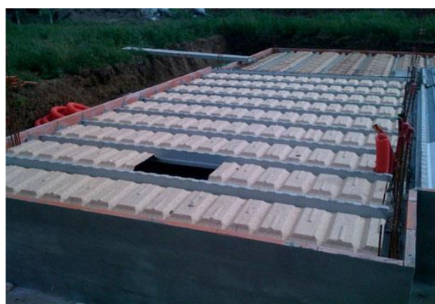
Figure I.17: Installation d'un plancher béton de PSE.
