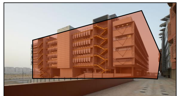
Figure I-17:Siège de Siemens à Masdar City source : (www.ArchDaily.com, 2019)
