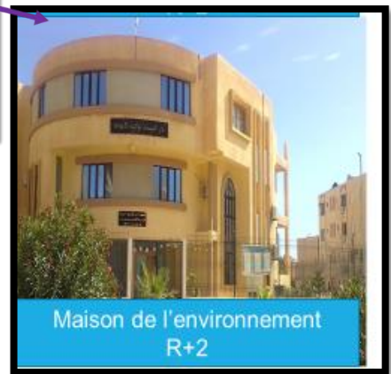
Figure II-18: maison de l'environnement source : auteure
