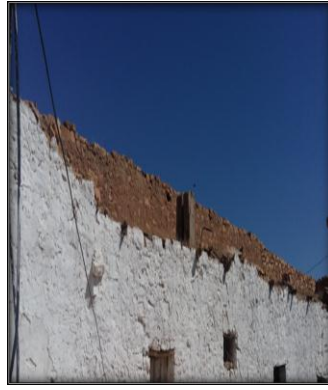
صورة رقم 120:سقوط سطح منزل الزوار المصدر الطالب
