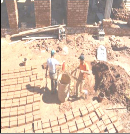
صورة رقم31: صناعة القوالب
