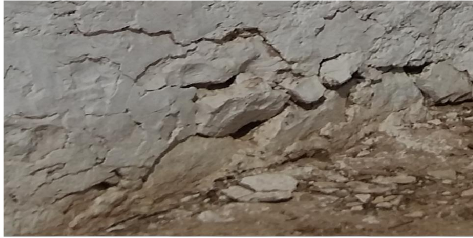
صورة رقم 11: توضح تدهور الحجار في الجدار
