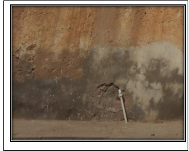
صورة رقم 2: توضح تدهور الأساسات
