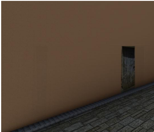
صورة رقم 8 : حالة الجدار بعد الترميم
