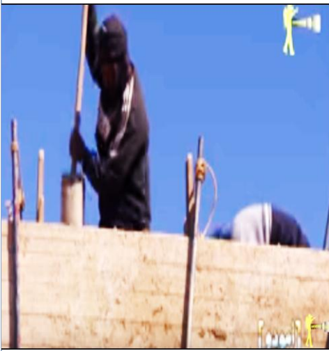
صورة رقم 32: طريقة بناء الحائط المدكوك
