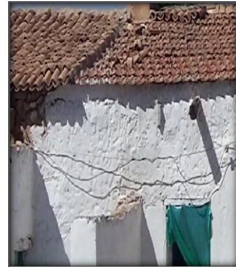
صورة رقم 113: توضح سقوط التلبس في المنازل المصدر الطالب
