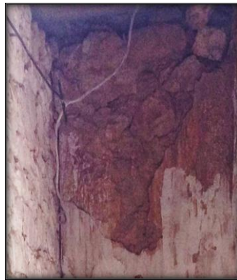
صورة رقم 114: توضح سقوط التلبس داخل المنازل المصدر الطالب
