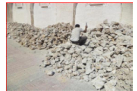
صورة رقم 16:استرجاع الحجارة لإعادة استعمالها
