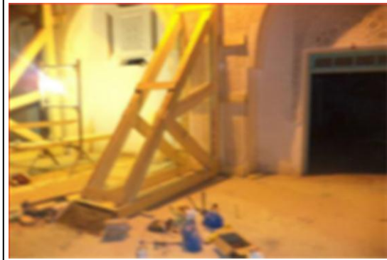
صورة رقم 20: المساند بالخشب للأقواس وللأعمدة المسجد سيدي حما لعروسي. المصدر: عن مكتب الدراسات المعمارية والمساعدة التقنية- خليبي عبد الحفيظ-ورقلة
