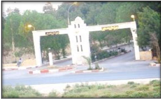
صورة رقم 94: توضح المدخل الرئيسي للزاوية لمصدر الطالب
