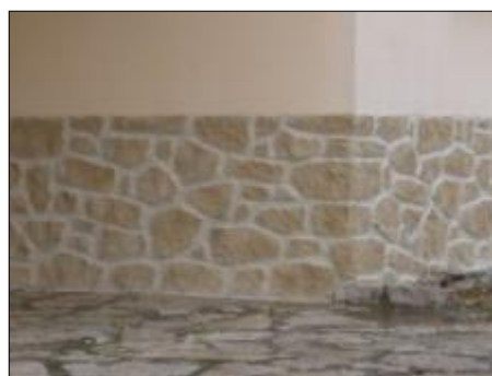
Photo III-55 : Soubassement en pierre sont visibles
