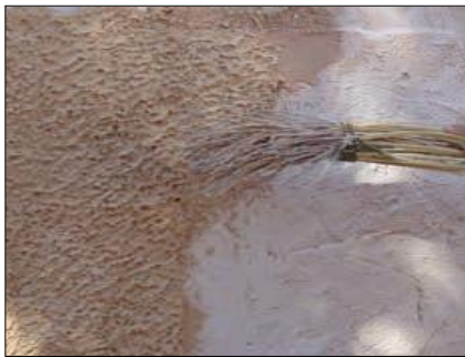
Photo III-53 : Crépissage l'Argoun
