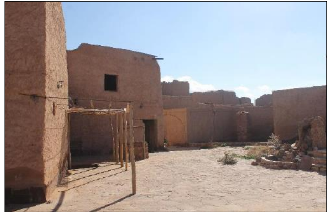
Photo II-21 : Vue sur la place (Djemaa) du Ksar de Boussemgoun
