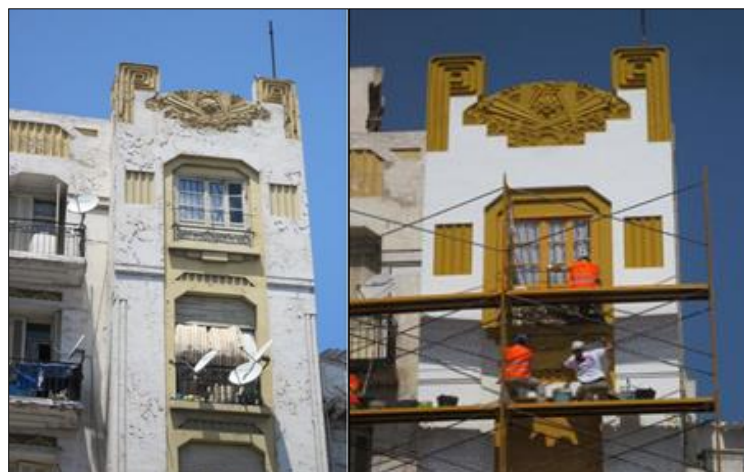
PhotoII-18 : Oran un riche patrimoine ; opération de réhabilitation, avant et après [51]
