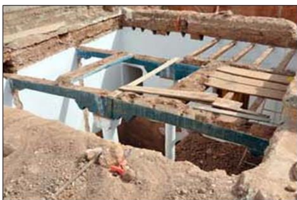
Photo II-24 : démantèlement de plancher[61]
