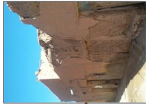
Fissures profondes et dégradation de cr a causé manque d'entretien et Fuite d pluie
