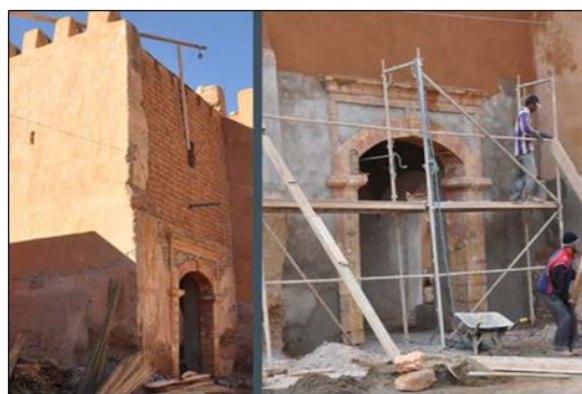
Photo II-25: le ravalement des façades[61]
