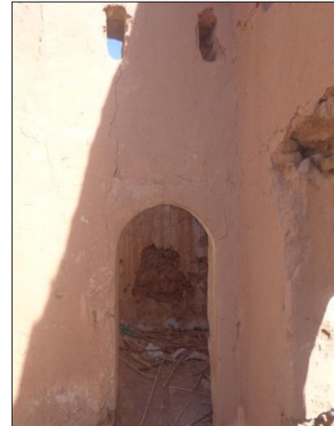
Photo III-59 : Arc pleine cintre
