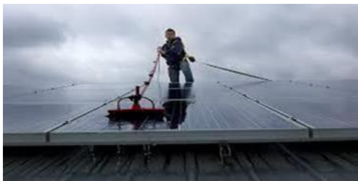
Figure III-17 : Image montrant le nettoyage par aspiration [42]
