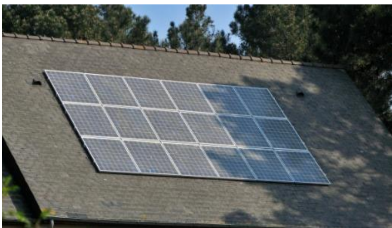
Figure II-10 : ombres des arbres sur les panneaux photovoltaïques [19]
