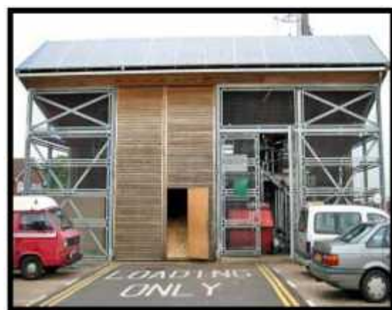
· Photo 24 : dépôt avec des panneaux solaires ;
