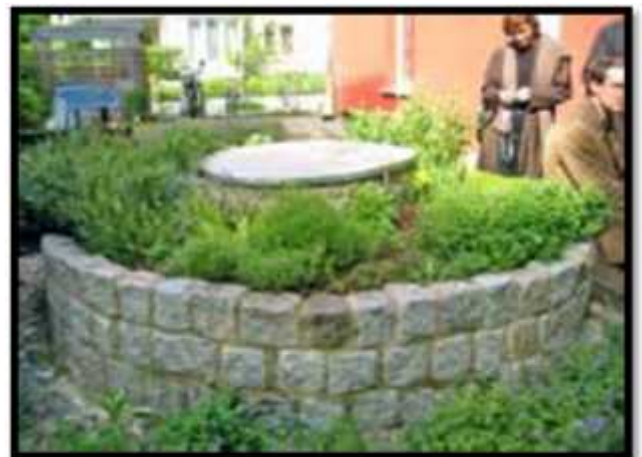
Photo 16 : d'un bassin d'orage végétalisé
