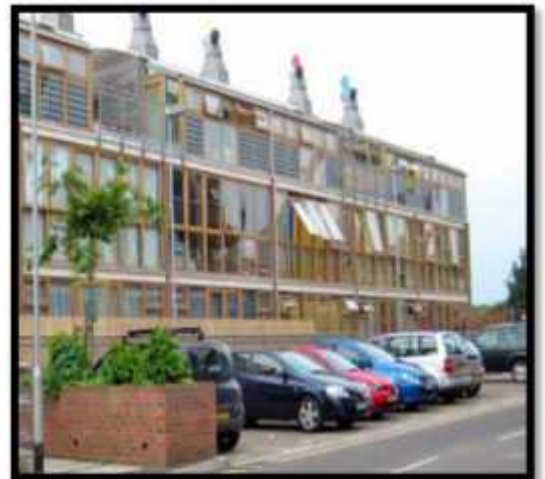
photo23 :des aires de stationnement pour véhicules. Source: www.google.com/quartiers bed-zed ;images .
