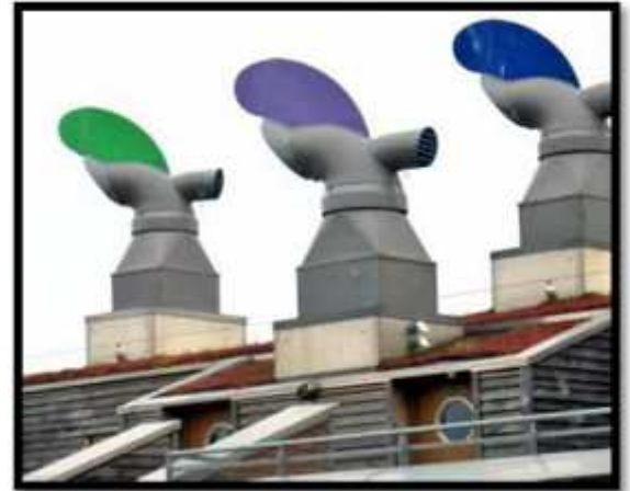
photo25 : des cheminées sur un toit
