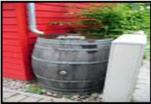
photo14 : une citerne de réservation des eaux pluviales ;
