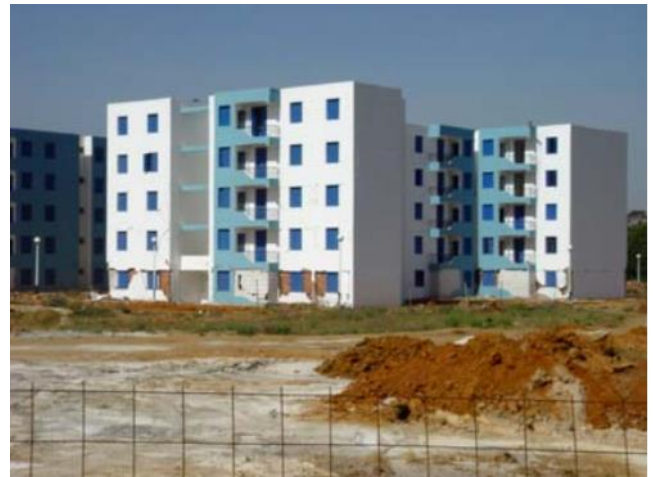
FigIII.3: On peut remarquer l'entaille au centre du bâtiment avec des poutres
