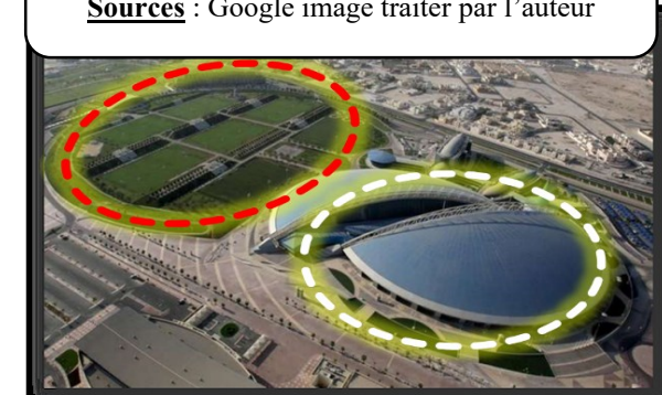
Figure 35 : vue sur le projet
