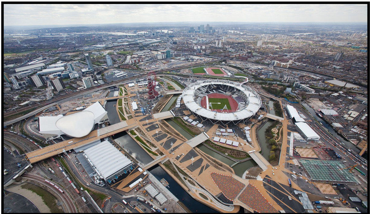
Figure 42 : Vue aérienne de projet Sources : Google image traiter par l'auteur
