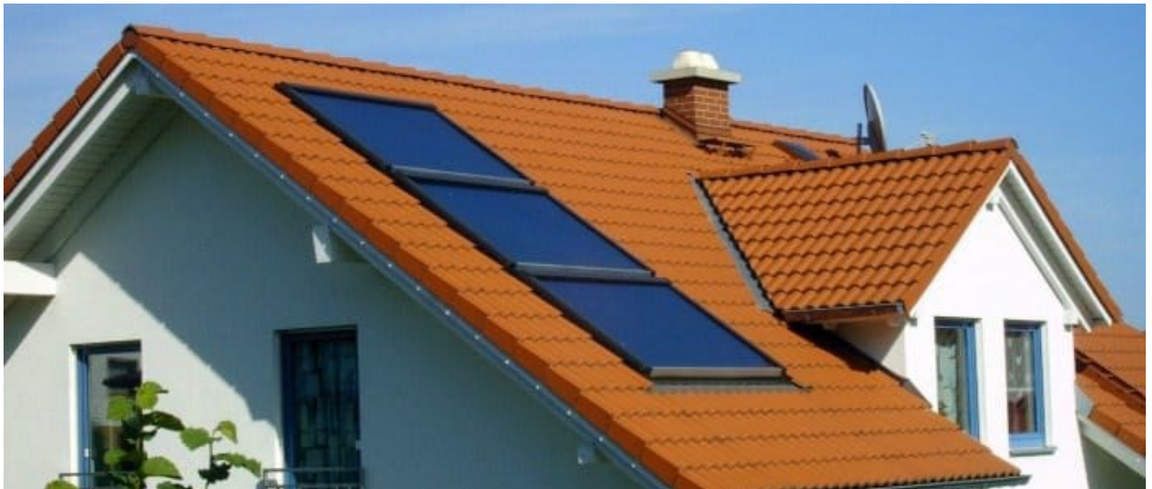
Fig.13: panneaux en toit
