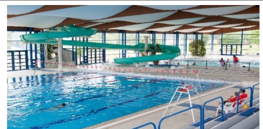
Figure 38 : vue sur le projet
