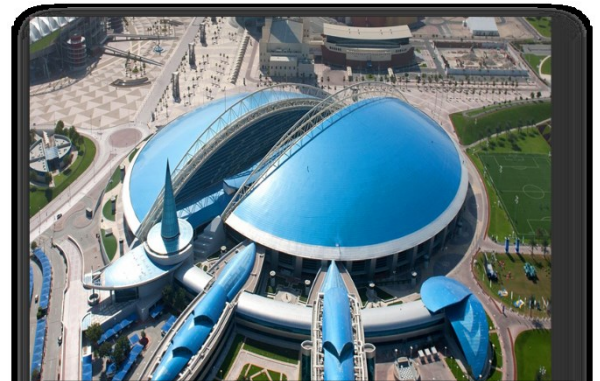
Figure 34 : vue sur le projet
