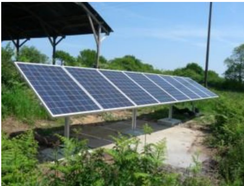
Fig.17 : panneaux hors bâti (Source : https://solabel.be/ )
