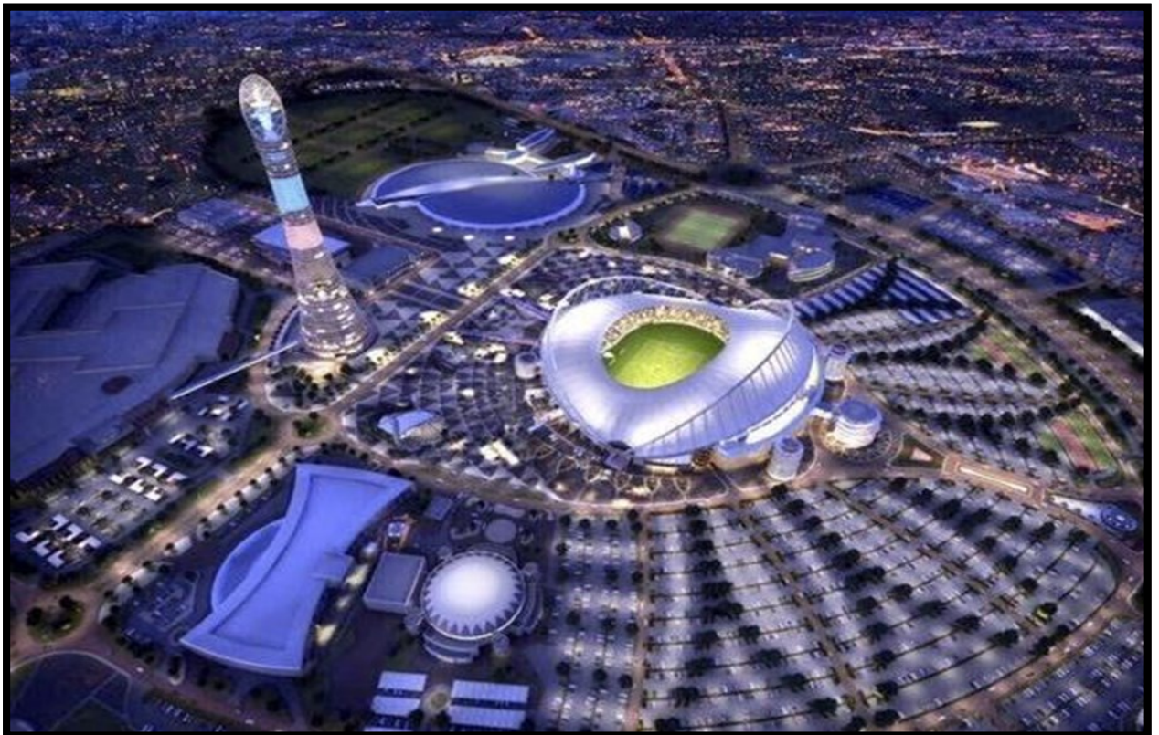
Figure13 : vue sur le projet
