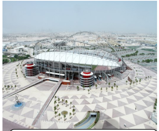
Figure 21 : vue sur le projet
