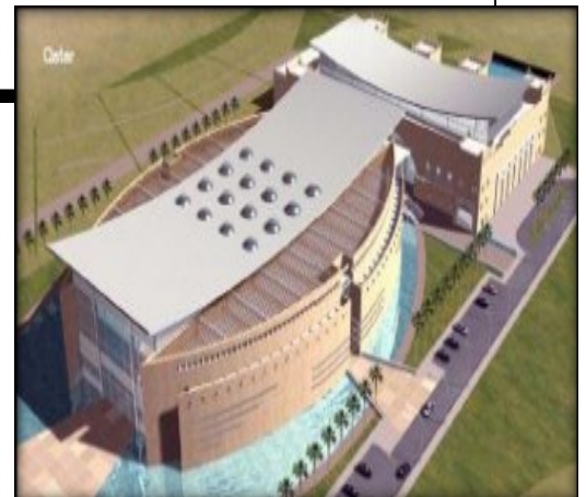
Figure 37 : vue sur le projet
