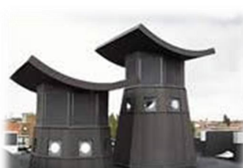
Figure 15 : les tours de ventilation
