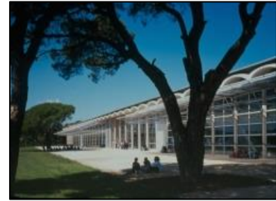
Figure 18: vue sur l'entrée lycée Albert camus
