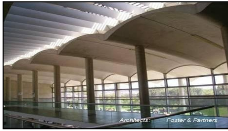
Figure 22 : les ventilles du verre réglables
