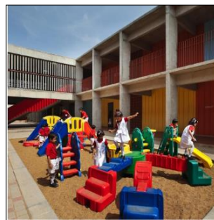
Figure16 : un mur de tôle ondulé brise soleil vertical et horizontal
