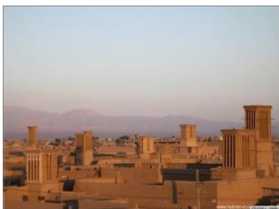
Figure 10 : vue sur la ville de Yazd
