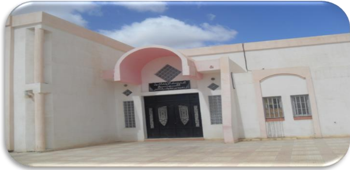
Fig. 28: la façade de primaire Dhina
