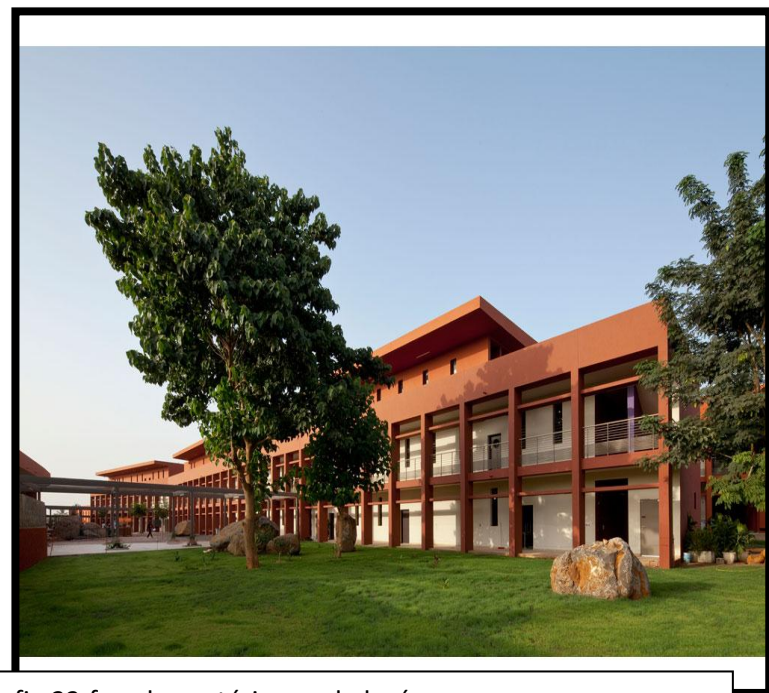
fig.33: façade postérieure du lycée- source:www.darchitectures.com
