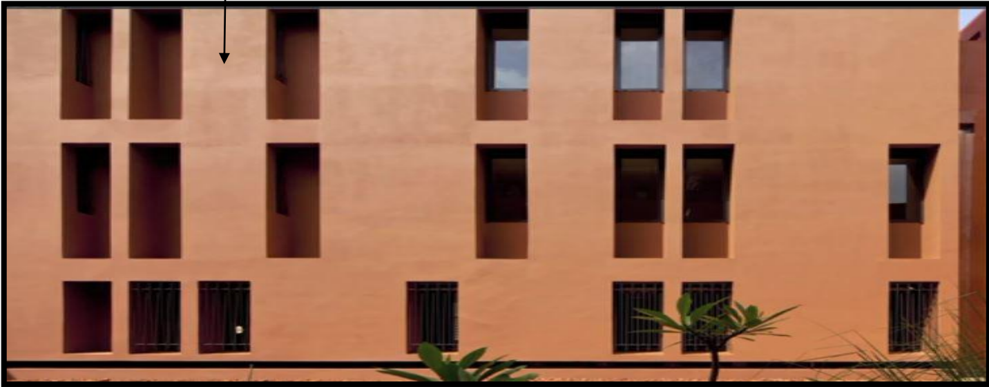
fig.36:le mur épaie du lycée -source: www.terreneuve.fr
