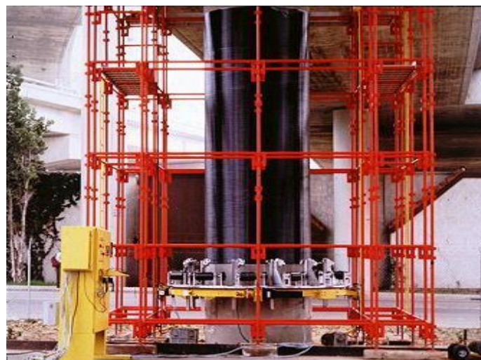
Figure 1.13: Système de confinement par appareil d'enroulement filamentaire.
