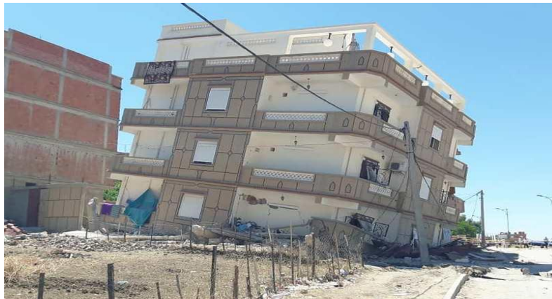
Figure 1.4: Tassement différentiel.
