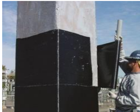
Figure 1.12: Confinement des poteaux par stratification directe.
