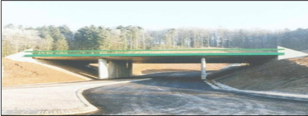
Fig. II.8: Exemple d'un « pont dalle ».
