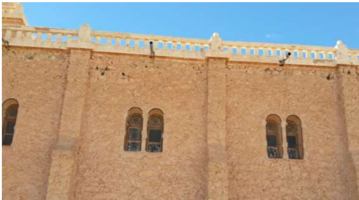
Figure 118: Le style des fenêtres. Source : Auteur EL-MENIA 2019.
