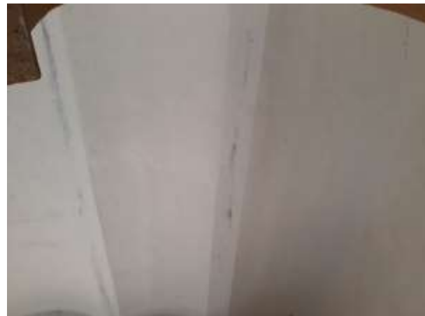
Figure 121: Les voutains et les IPN dans le plancher
