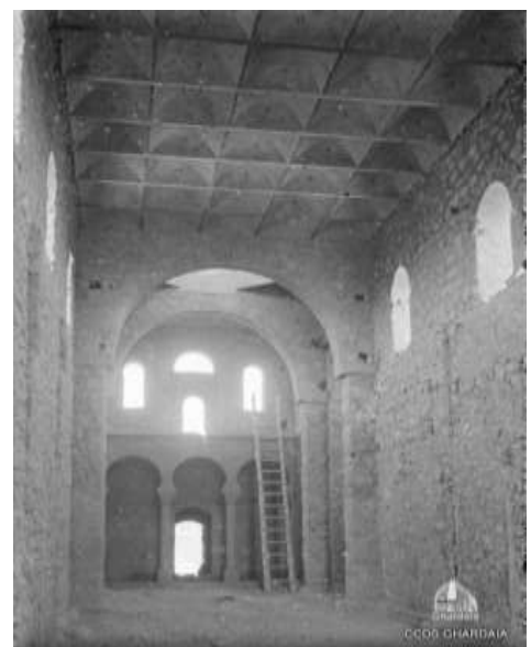
Figure 62: L'église en construction.
