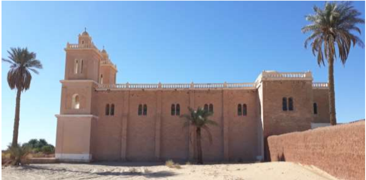
Figure 117: Façade Latérale. Source : Auteur EL-MENIA 2019.
