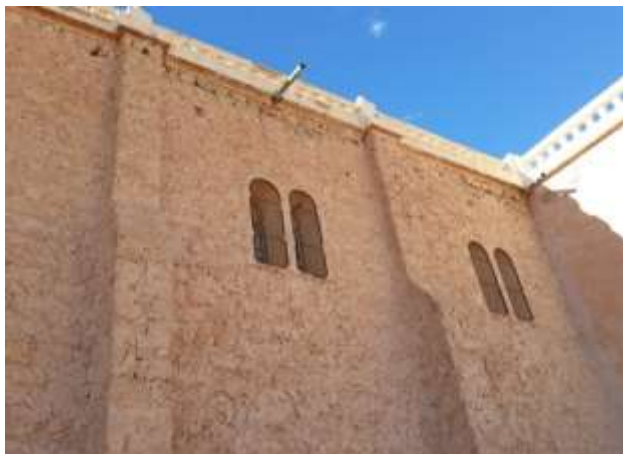
Figure 108: Les contreforts en pierre.
