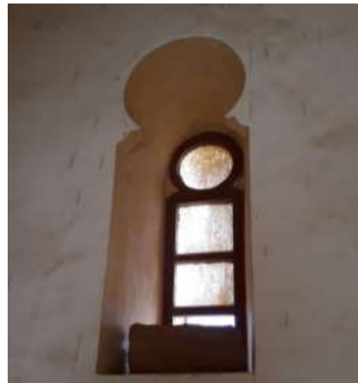
Figure 112 : Une fenêtre en bois.
