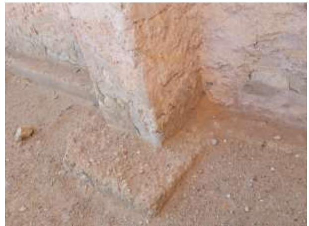
Figure 109: les fondations en pierre.
