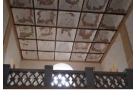
Figure 110: Les IPN du plancher dalle à caissons.
