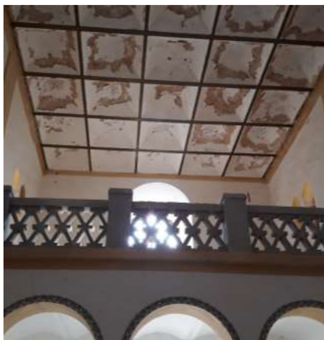
Figure 131: Plancher du type dalle à caissons
