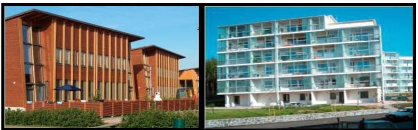
Figure N°12 : les grandes surfaces de vitrage dans les bâtiments, Source: www.helsinginenergia.fi/kaukolampo/ekoviikki.html
