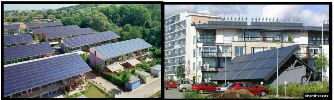
Figure N°11: le panneau solaire et photovoltaïque utiliser dans les bâtiments du quartier, Source : www.helsinginenergia.fi/kaukolampo/ekoviikki.html
