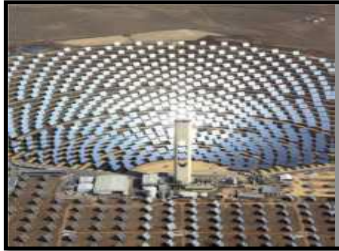
Figure N°93: Centrale solaire thermique pour production d'électricité (150 MW) (Boutarfa, Algérie) Source : www.envinergy-transactions
