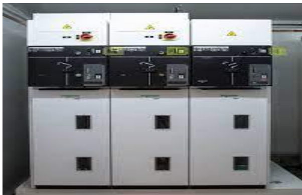
Fig.17/18 : Cellules HT/MT et MT/BT
