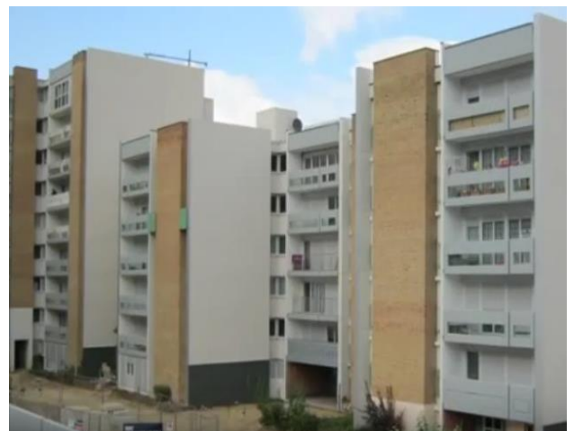
Figure 17 : Réhabilitation des bâtiments
