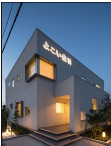
Figure 61: éclairage à l'extérieur
