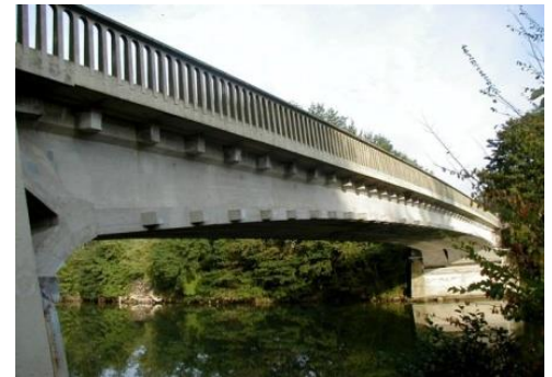
Figure I-4: Pont de Luzancy (Seine-et-Marne). Pont à béquilles
