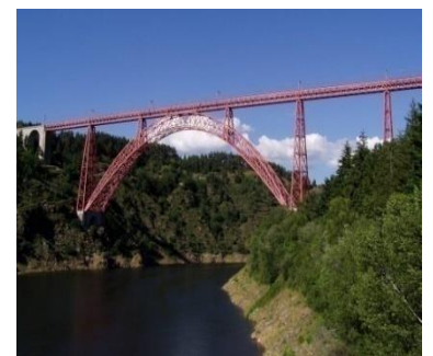
Figure I-2 Viaduc de Garabit (Cantal) en 1884 avec une portée de 165m
