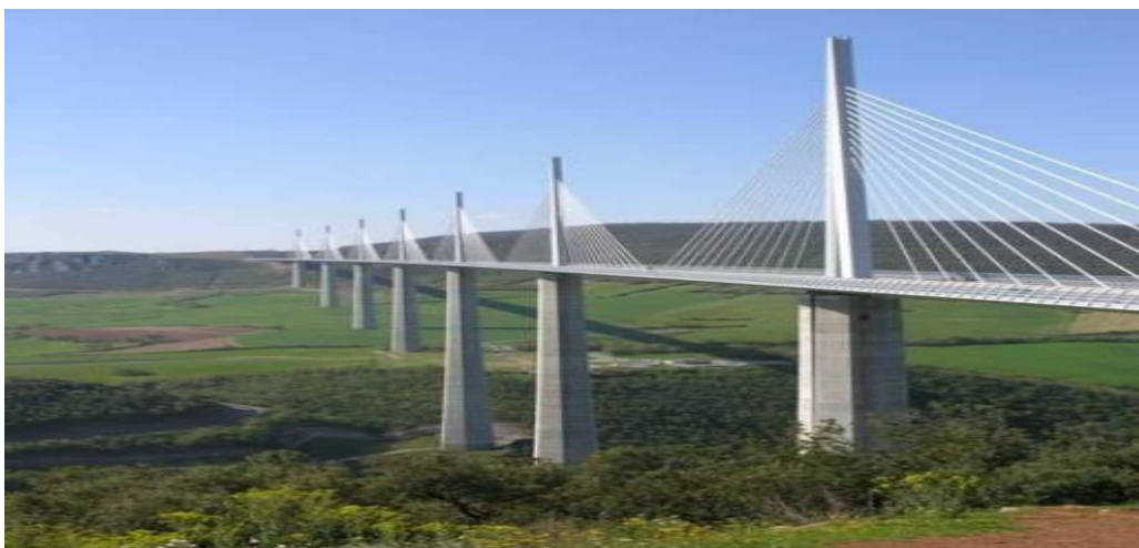
Figure I-7: Pont à haubans
