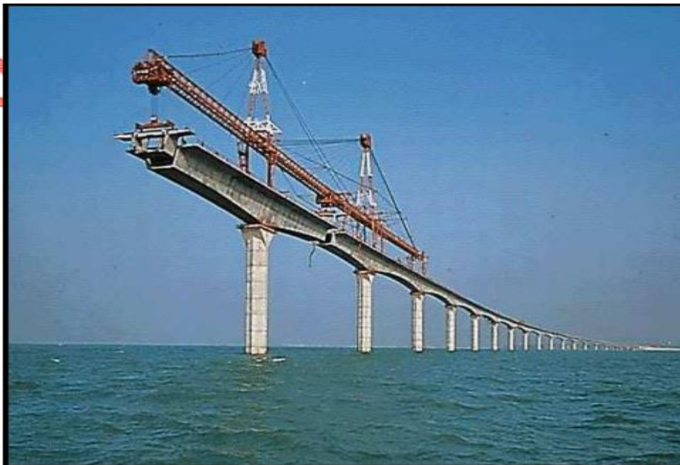
Figure I-12: Pont à caisson
